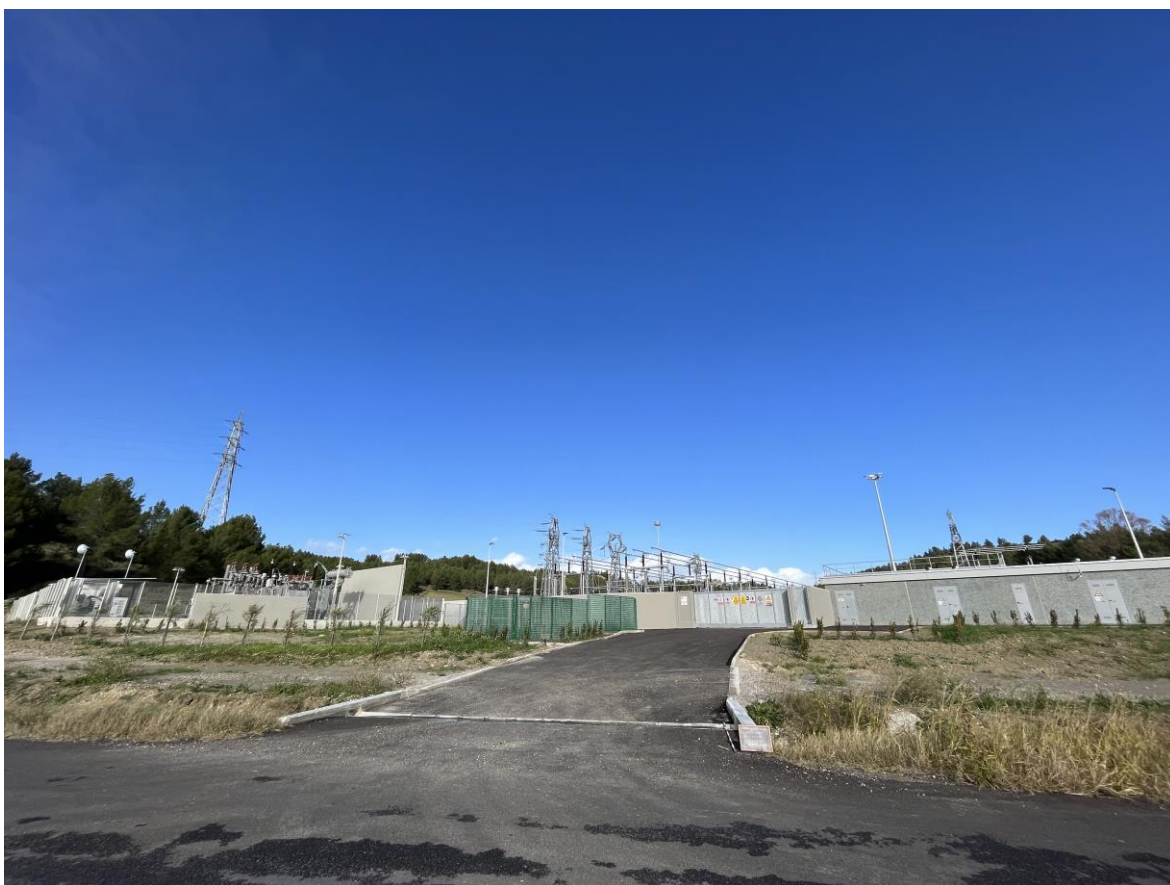
Figura 37. Craco (MT). Località Peschiera. Stazione Elettrica
