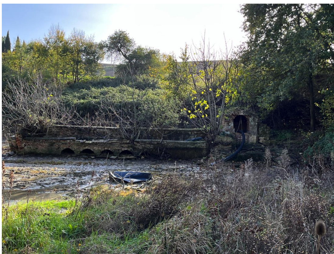
Figure 19-20. Stigliano (MT). Masseria S. Meaito. Cavidotto WTG 06.
