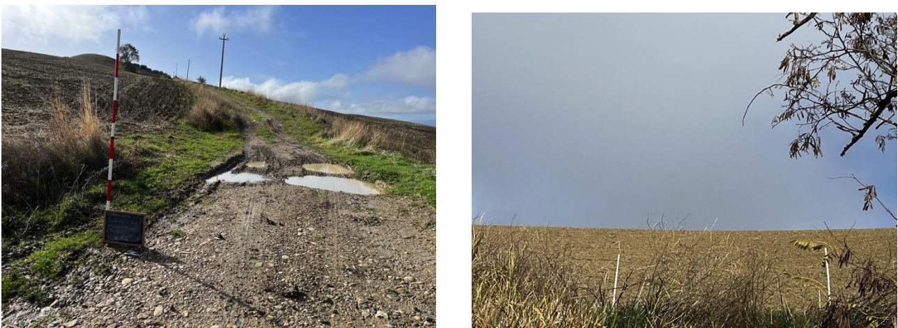
Figura 15. Stigliano (MT). Tipico S. Meaito, WTG 04-cavidotto-aerogeneratore.
