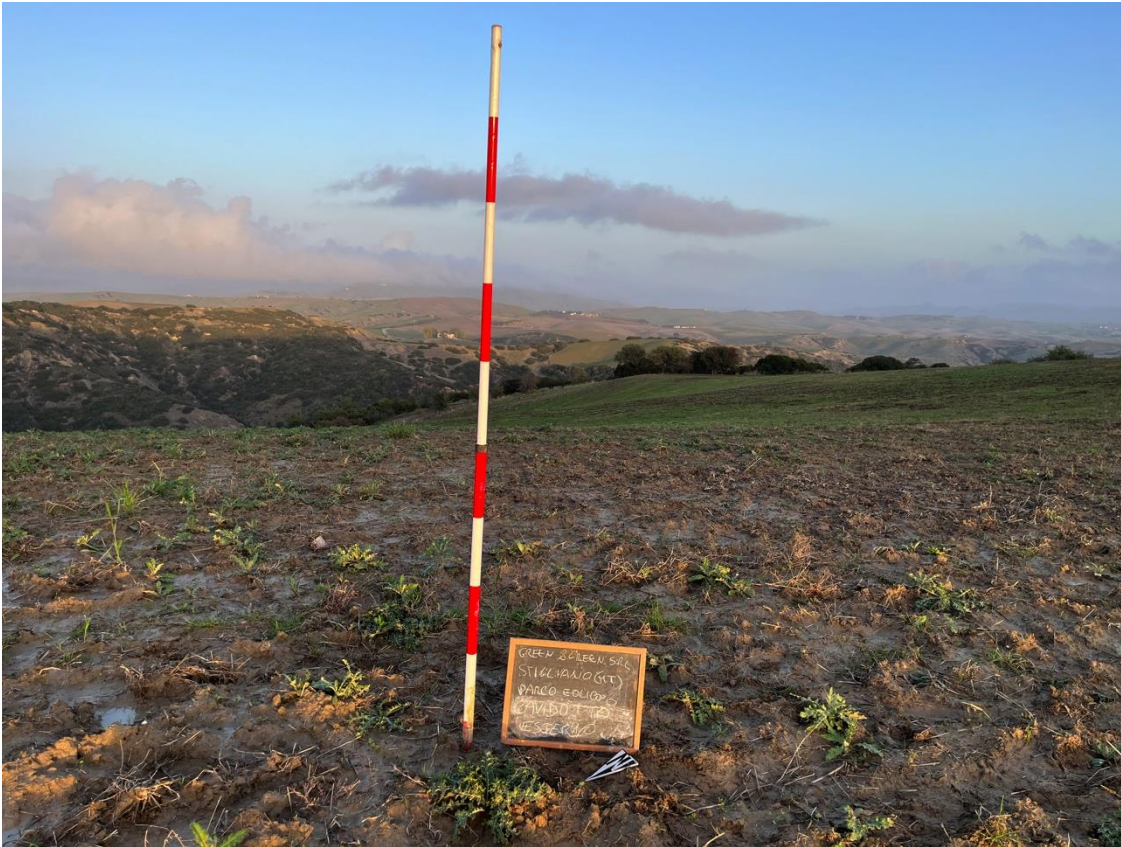
Figure 34. Stigliano (MT). Località Salemme. WTG 09-inizio cavidotto esterno.
