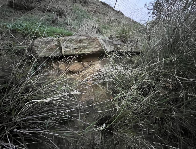
Figure 21. Stigliano (MT). Cavidotto WTG 07-08.
