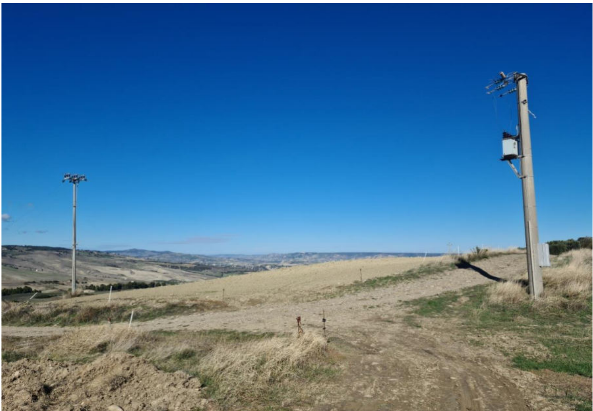
Figura 103 – Foto n. 14: Area di realizzazione nuova strada a servizio della WTG4
