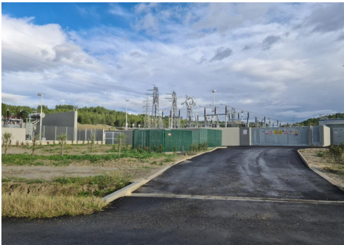
Figura 114 – Foto n. 22: Stazione elettrica di Craco realizzazione cavidotto in entrata su suolo non agricolo
