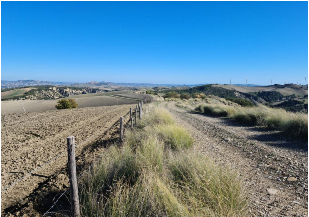
Figura 105 – Foto n. 16: Area di realizzazione nuova strada per leggera modifica del tracciato tra WTG4 e WTG5
