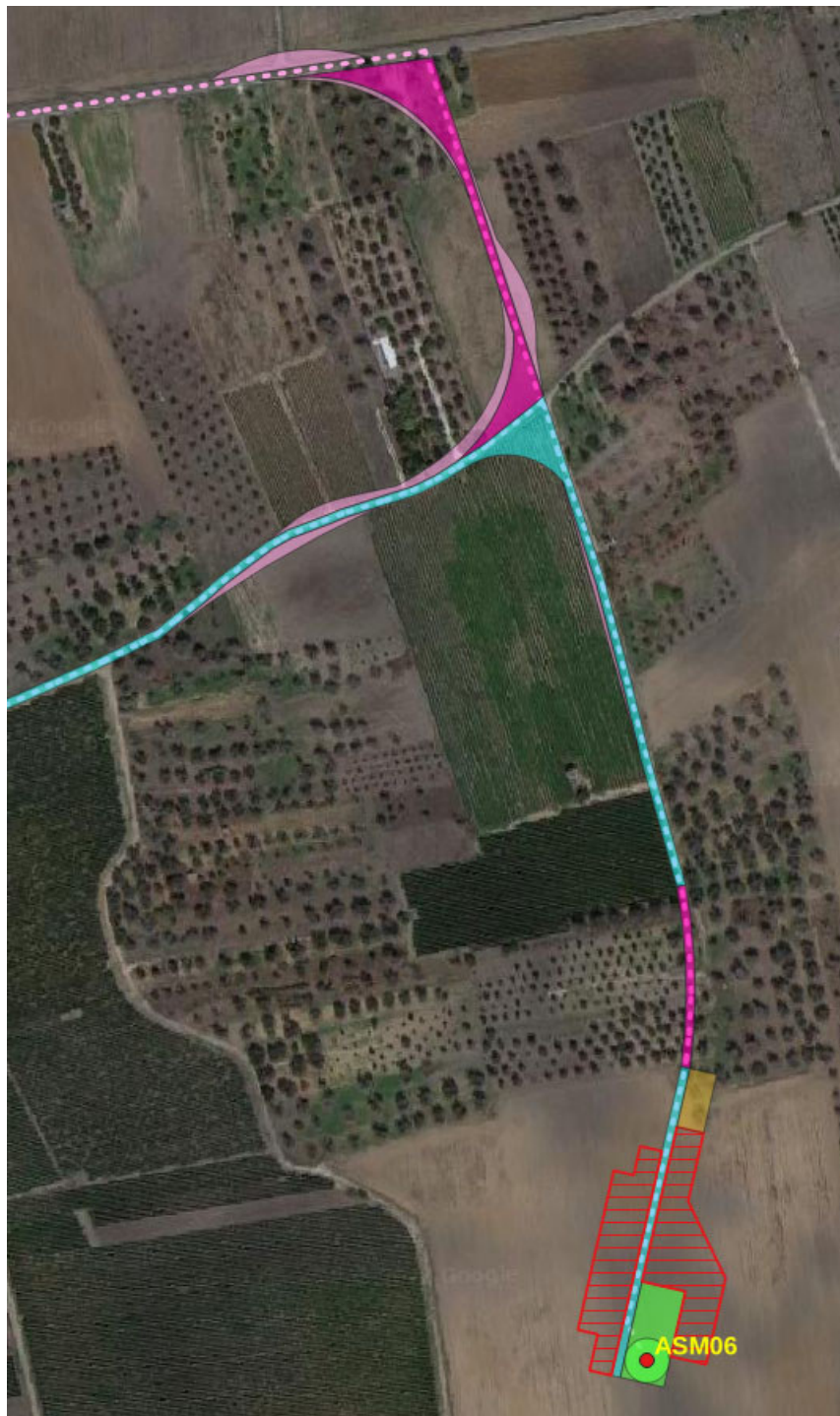
Sito di installazione WTG ASM06 (Google satellite 2021)
