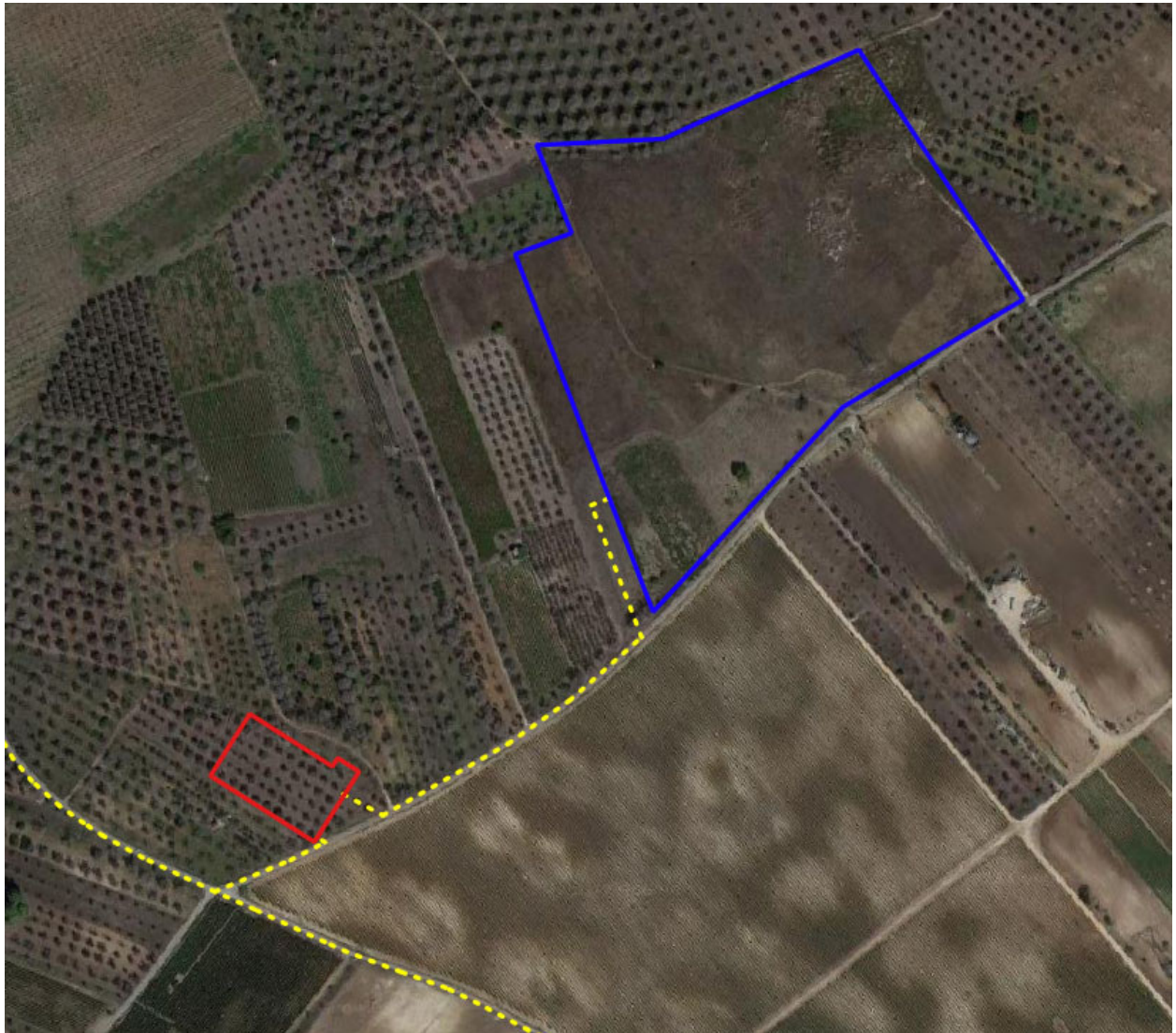
Siti di installazione della Cabina SSE (in rosso) e della Stazione Terna (in blu) (Google satellite 2021)
