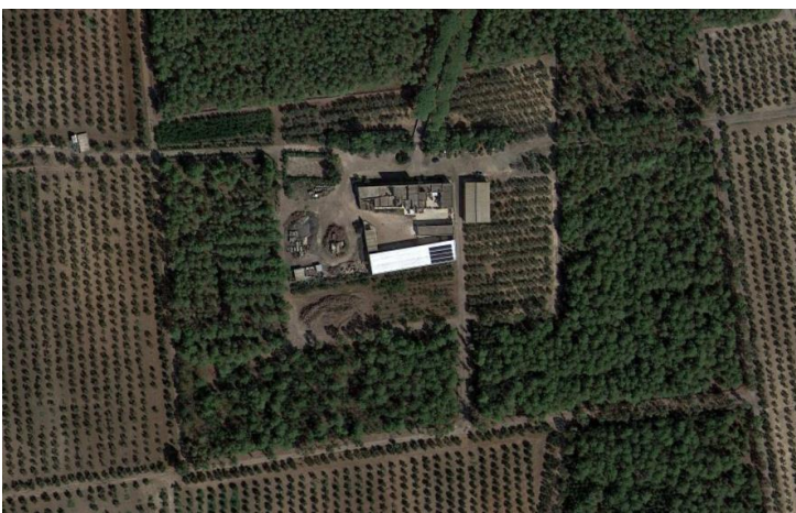
Figura 127 - ricettore ID 60 E La masseria Orsi non è raggiungibile essa si presenta quasi totalmente diruta.
