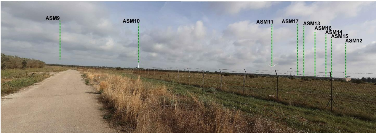
Figura 105 -stato dei luoghi ex post ID 33AB_Pv1
