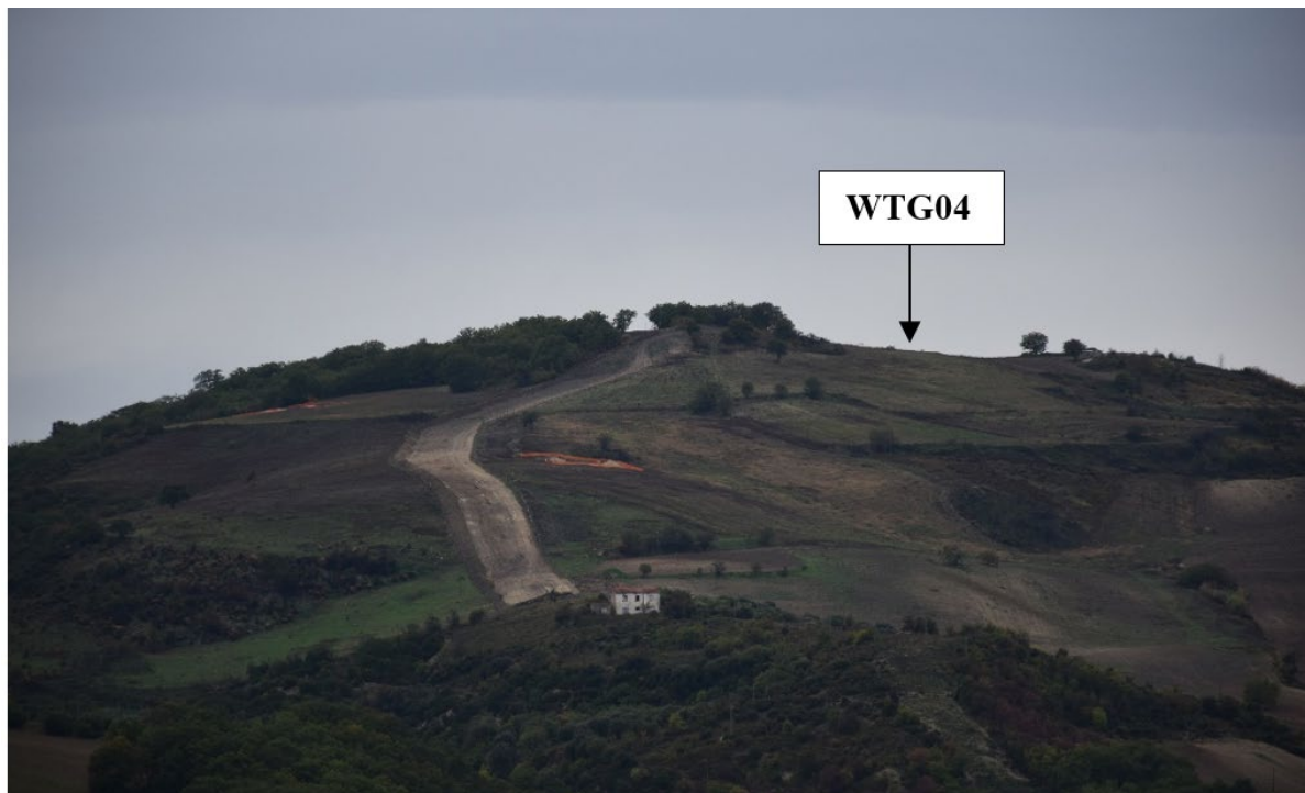
Figura 15 Vista dall'area di ubicazione dell'aerogeneratore WTG04. sulla sinistra si nota lo scavo per la posa del metanodotto.
