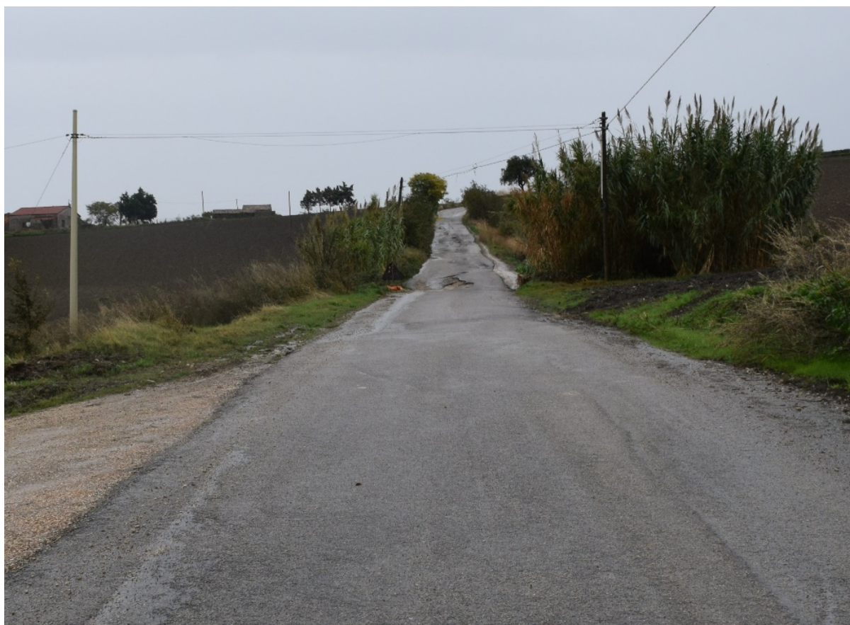
Figura 18 Vista della strada comunale Guardiola da adeguare
