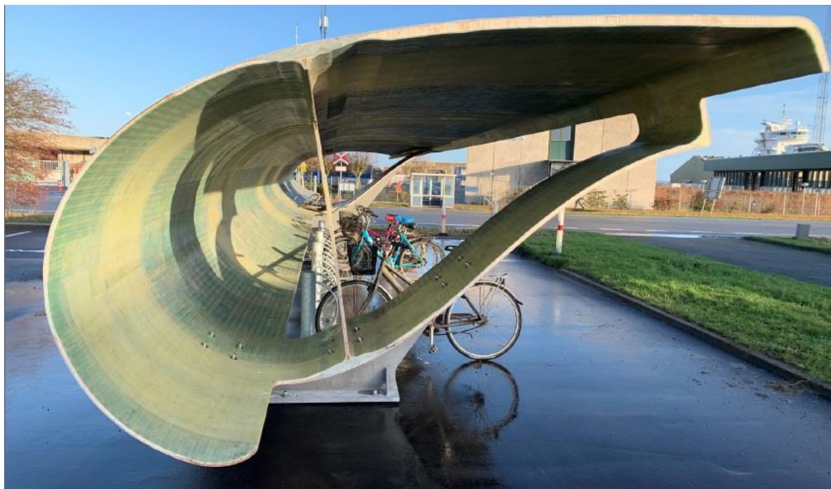
Figura 5 Esempio di riutilizzo della pala come pensilina per biciclette ad Alborg, Danimarca (fonte: Accelerating wind turbine blade circularity)
