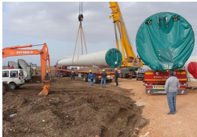
**Figura 6:** elementi torre smontata da trasportare
