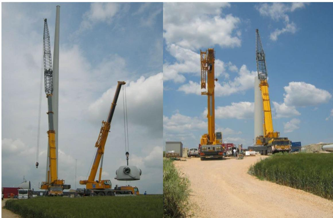
**Figura 3:** smontaggio navicella
