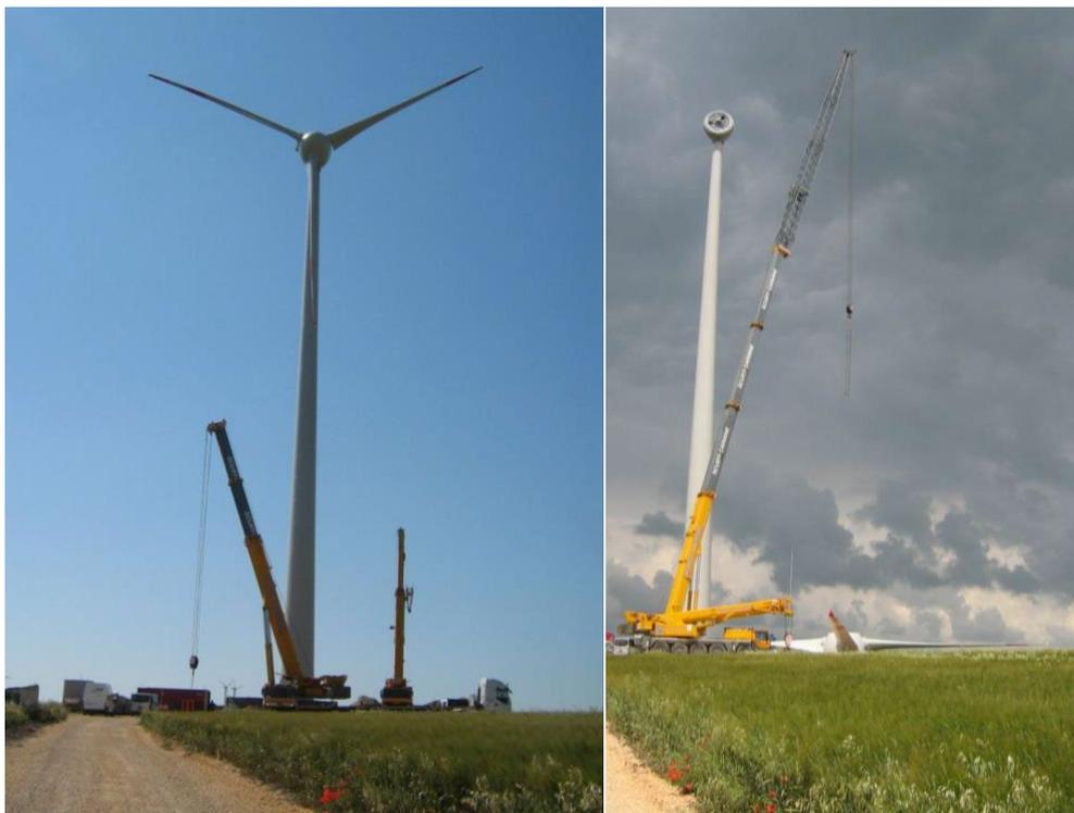
**Figura 2:** rimozione eliche e mozzo
