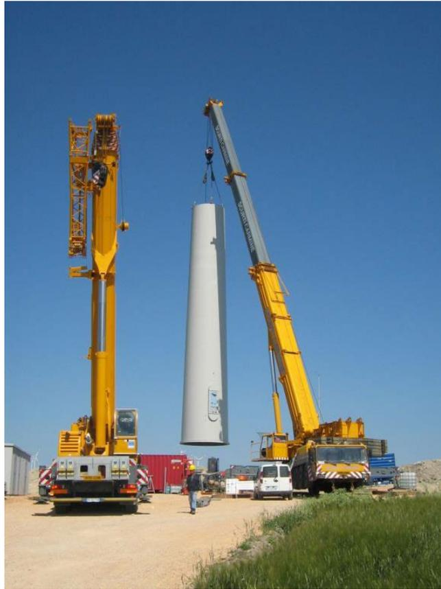
**Figura 5:** elemento torre smontata da trasportare
