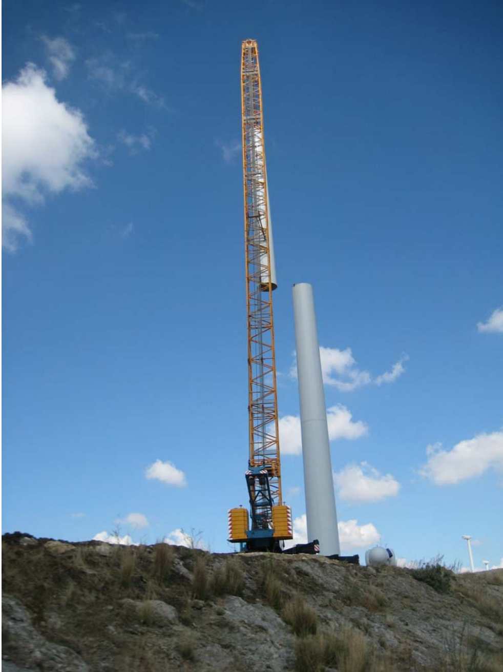
Figura. 61 – Attività di smontaggio degli elementi in acciaio di forma tronco-conica costituenti il sostegno dell'aerogeneratore
