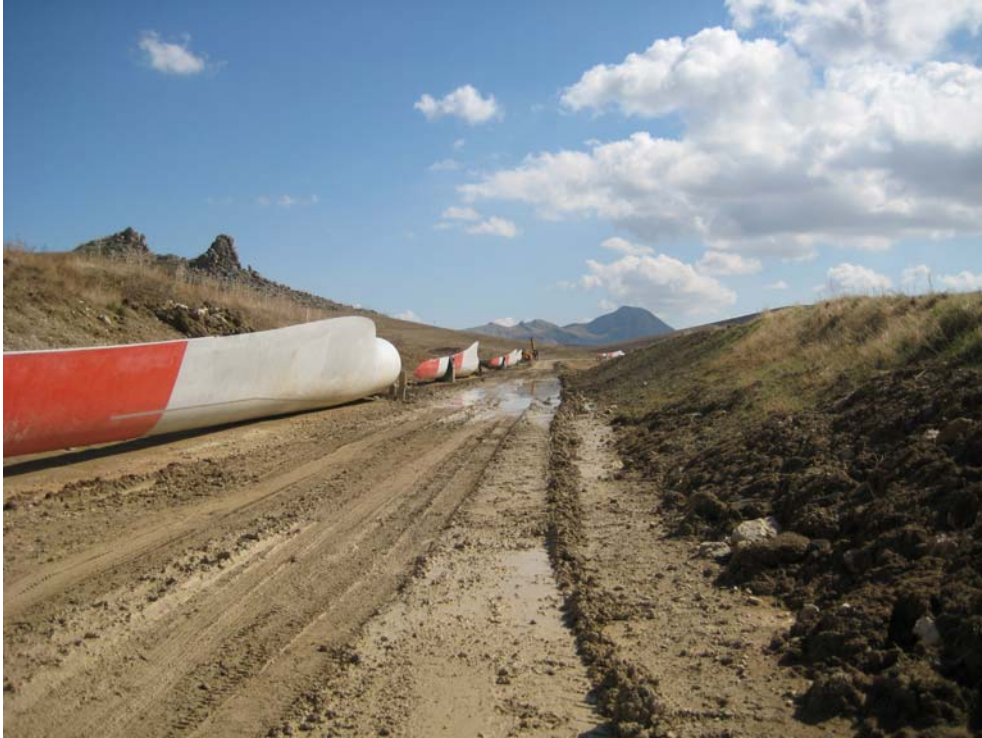
Figura. 57 – Blade costituenti il rotore smontato
