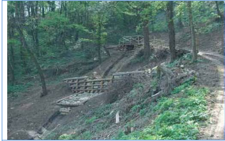
Figura 61 – Esempio di briglie in legname e pietrame - Fonte HE
