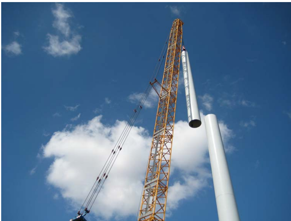
Figura. 19 – Attività di smontaggio degli elementi in acciaio di forma tronco-conica costituenti il sostegno dell'aerogeneratore
