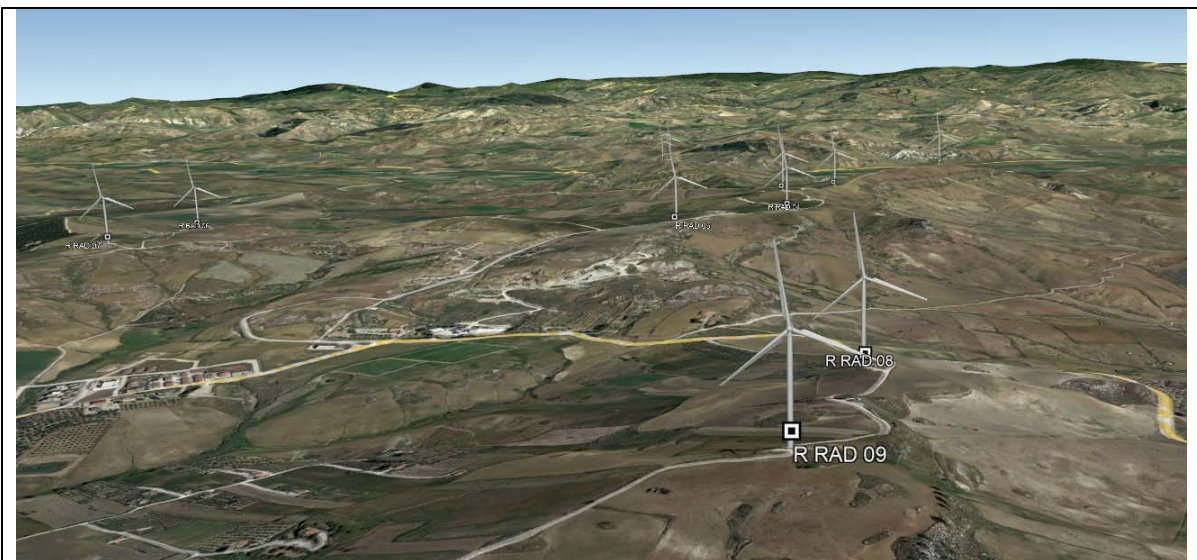
Figura 11 – Vista globale degli aerogeneratori che occupano i crinali a ovest del sito oggetto di intervento (inquadratura sud-nord)
