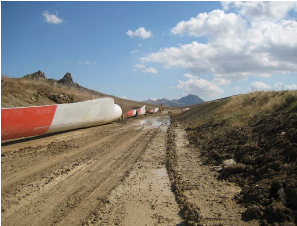
Figura. 16 – Blade costituenti il rotore smontato
