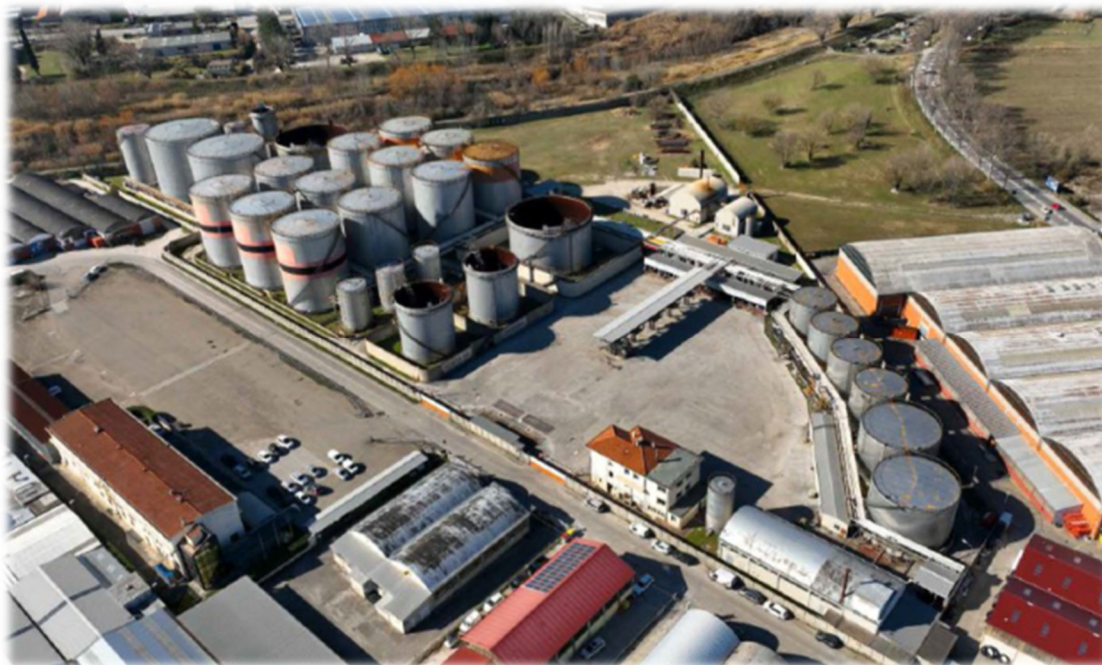
Figura 11-2 – Stato attuale dell'impianto FOX
