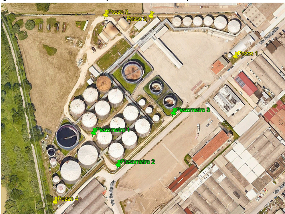
Figura 10-11 – Posizionamento e pozzi antincendio nel deposito costiero Fox Petroli
