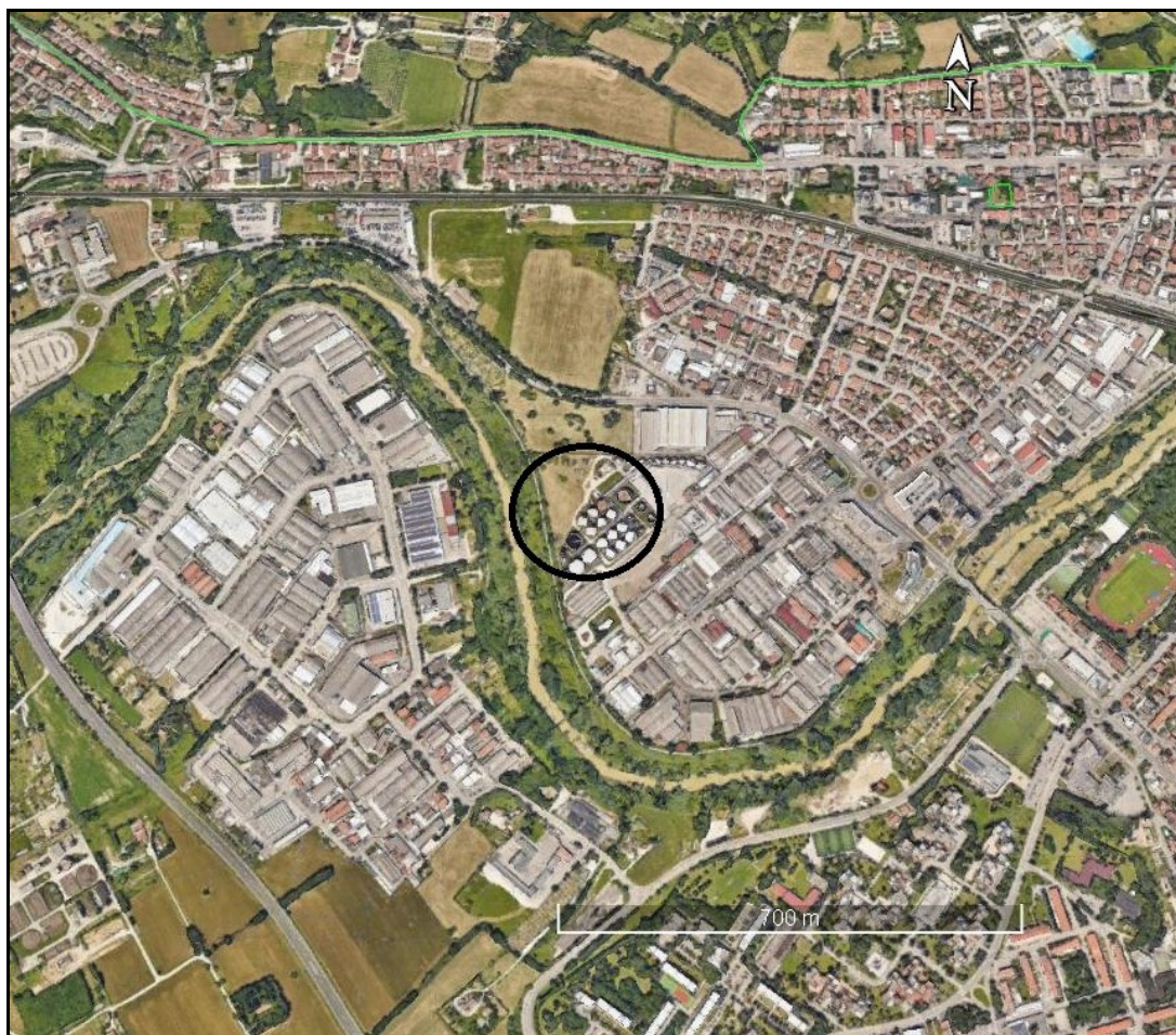
Fig. 2.1.A – Stralcio ortofoto con localizzazione area di intervento. Cerchiata in nero l'area nella quale si inseriscono le opere in progetto.
