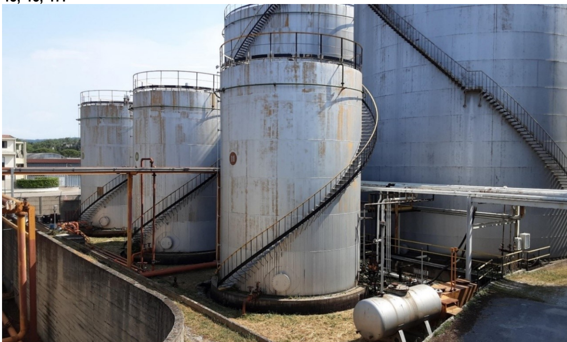
FOTO 10 – INQUADRAMENTO DALL'ALTO ZONA SERBATOI IN DISMISSIONE N. 9, 10, 11, 45, 46, 47.
