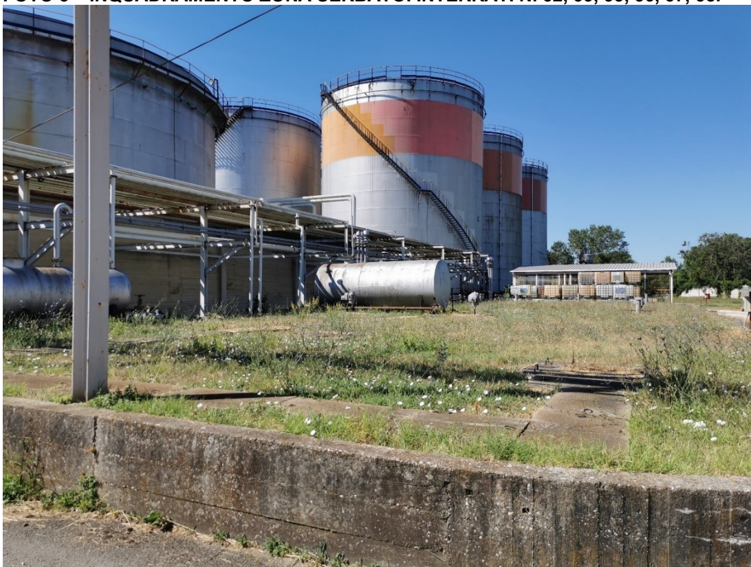
FOTO 5 – INQUADRAMENTO ZONA SERBATOI INTERRATI N. 32, 33, 35, 36, 37, 38.
