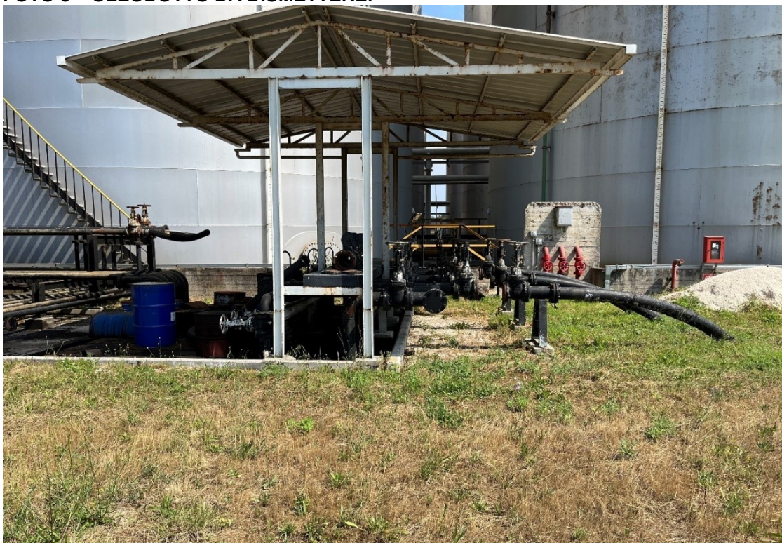
FOTO 8 – OLEODOTTO DA DISMETTERE.
