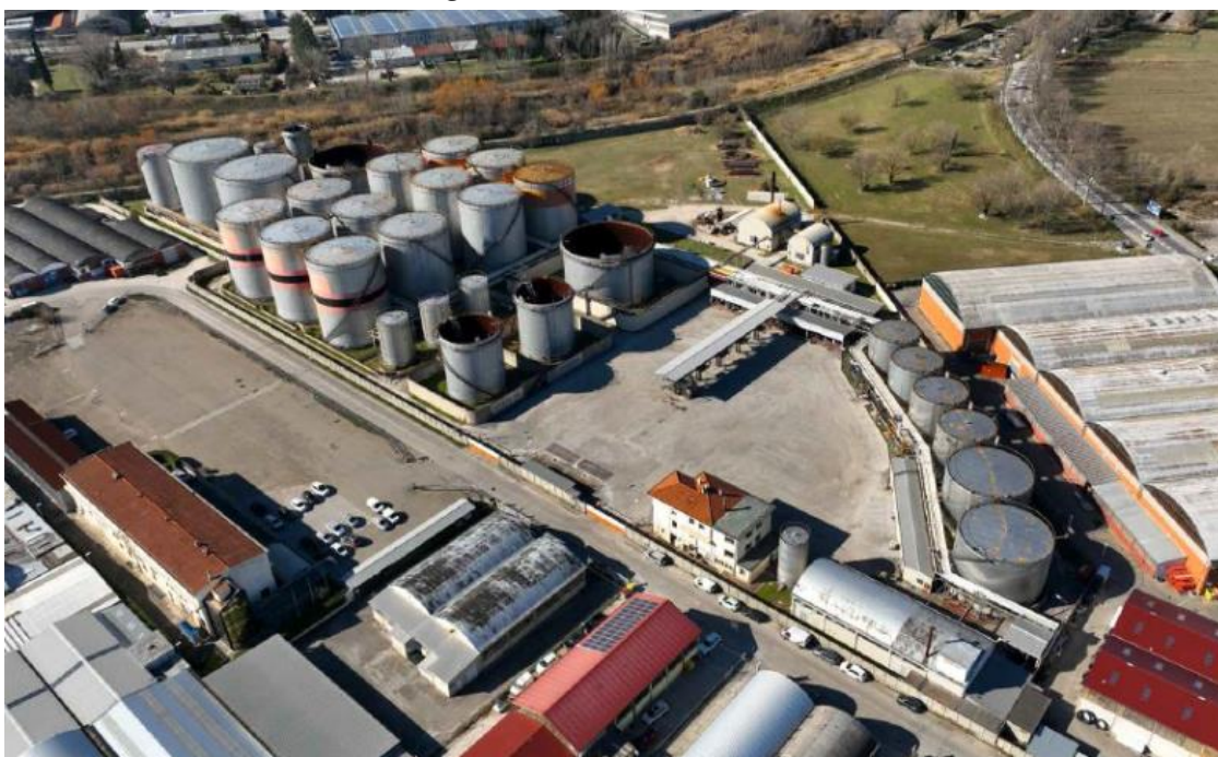
Figura 4-3 – Stato di fatto
