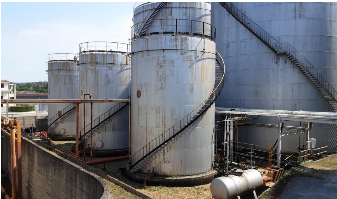
Figura 4-2 – Inquadramento dall'alto zona serbatoi in dismissione n. 9, 10, 11, 45, 46, 47
