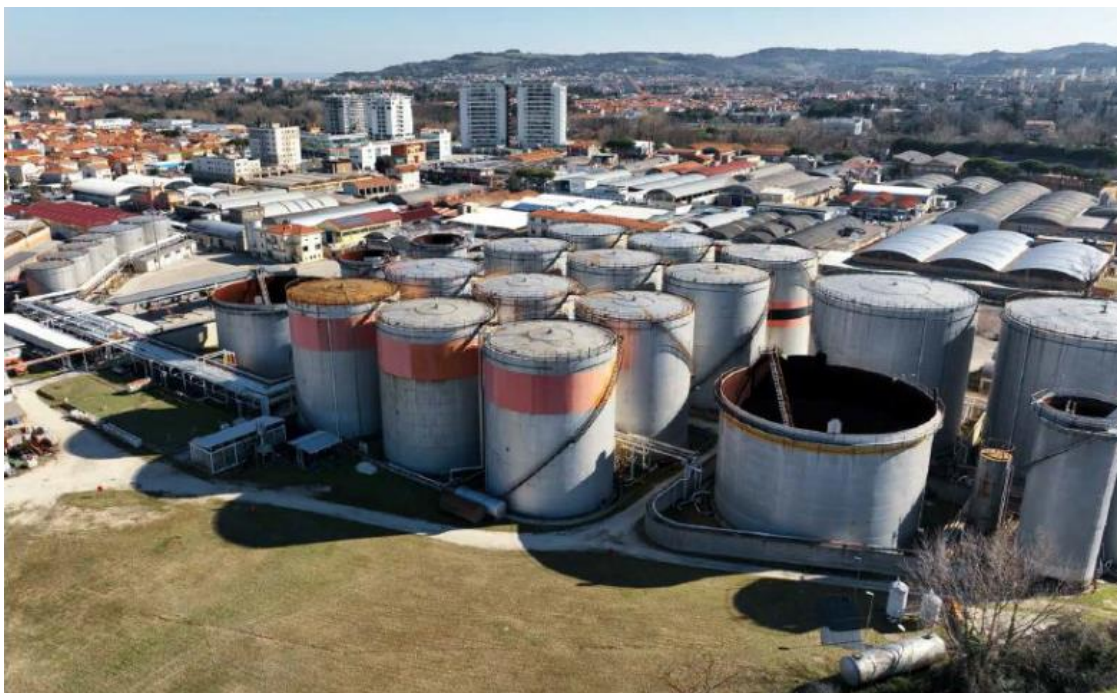
Figura 4-5 – Stato di fatto
