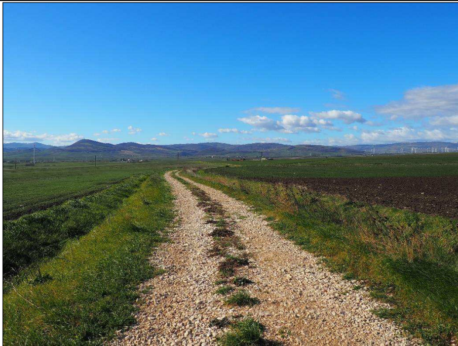
Foto 18.1–SP113 - visuale sud sud ovest
