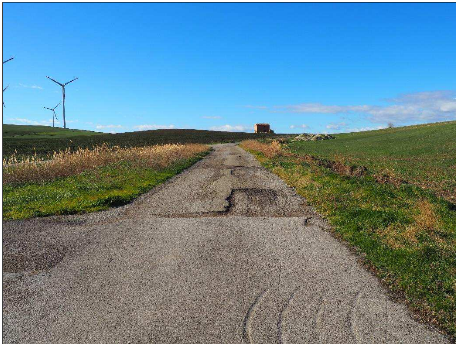
Foto 14.1–SP113 - visuale sud sud ovest
