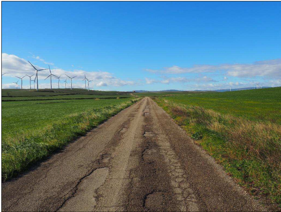
Foto 12.1–SP114 - visuale sud sud ovest
