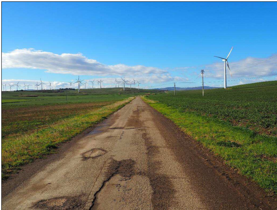
Foto 11.1 –SP114 - visuale sud sud ovest
