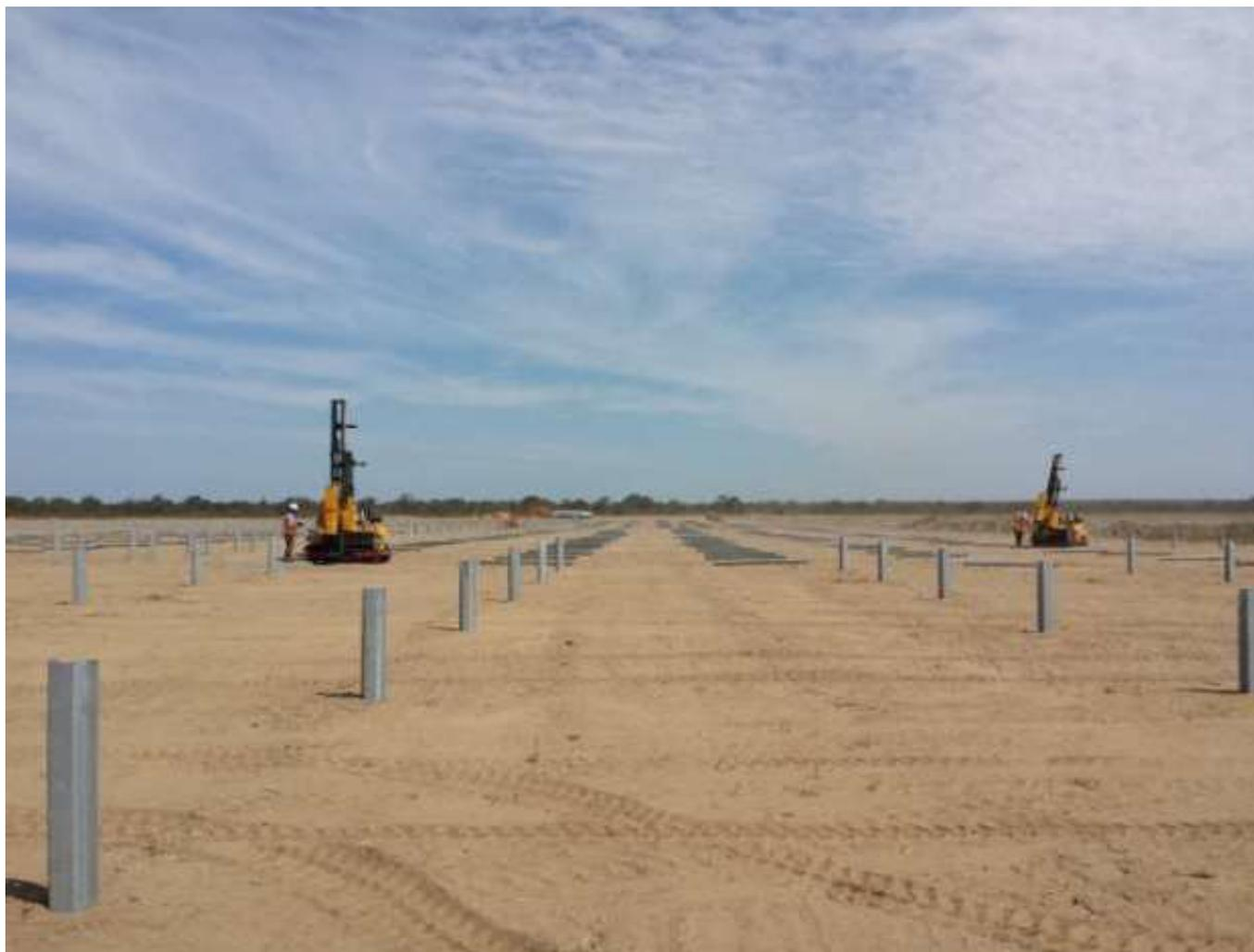
*Figura 33 - Esempio di disposizione dei pali di fondazione delle strutture*
