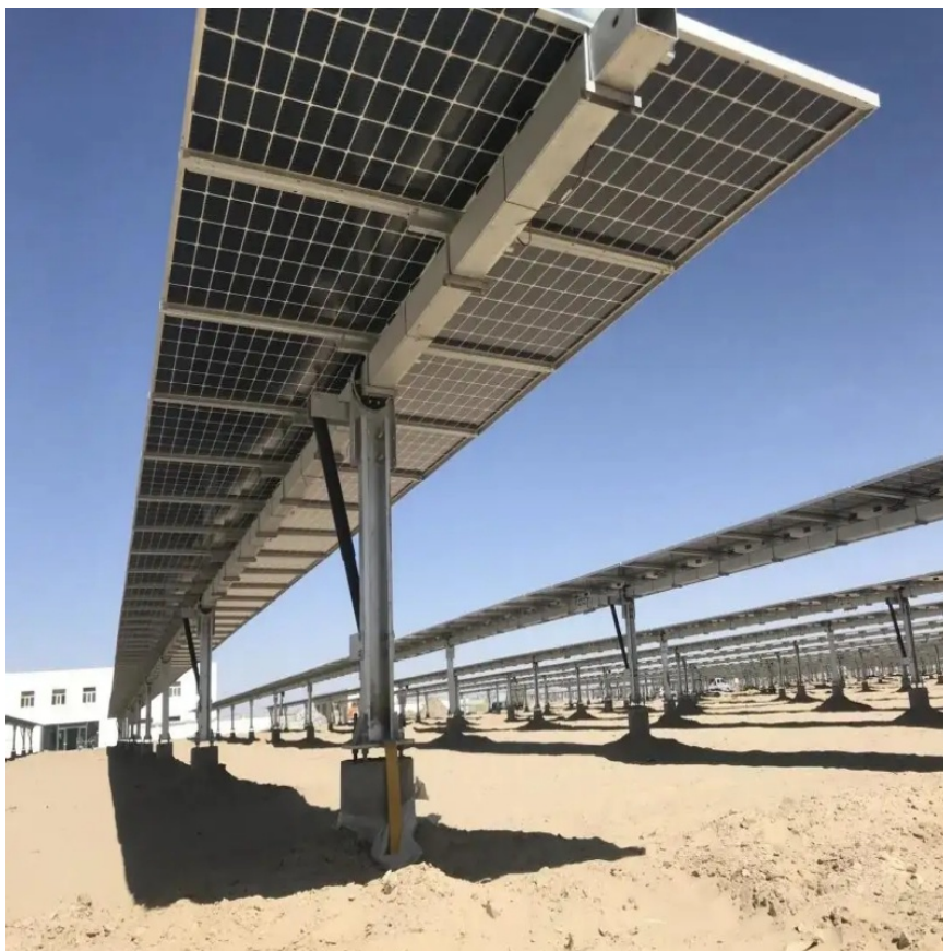
Figura 7: Sistema tracker - inseguitore solare- tipo monoassiale single portrait
