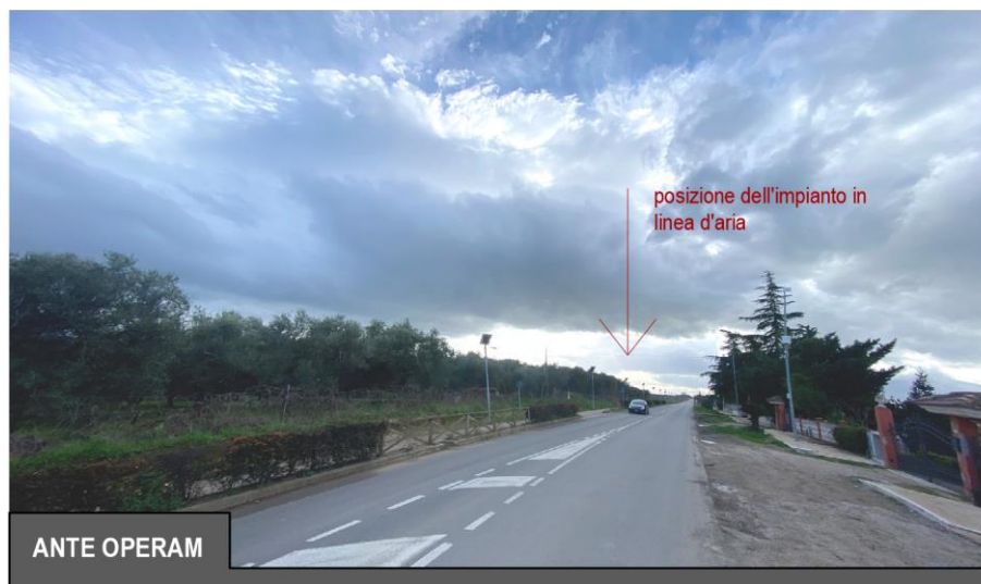
Figura 36 - F.1 Ante operam - Post operam
