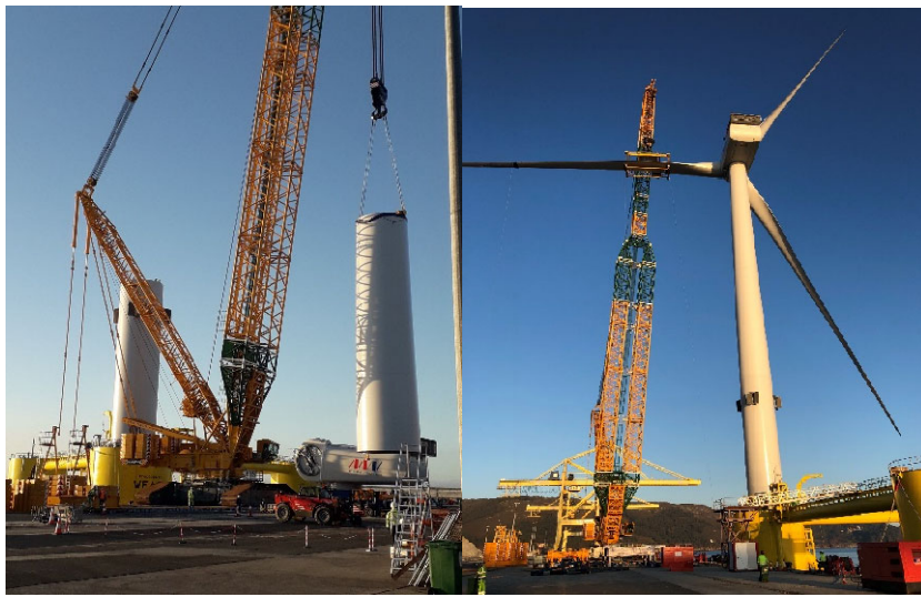
Figura 6.3 Installazione della torre e della turbina
