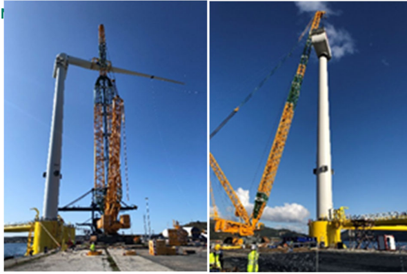
Figura 4.9 Installazione della turbina eolica
