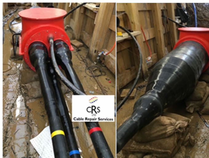
Figura 4.14 Giuntura di transizione sulla terraferma
