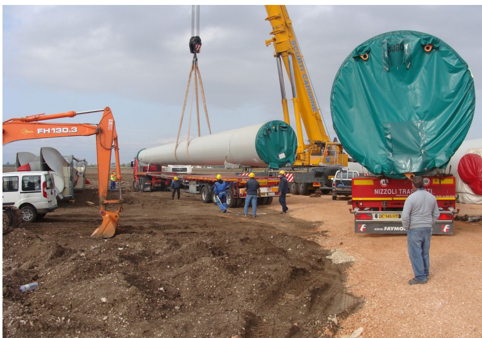
Figura 6: elementi torre smontata da trasportare
