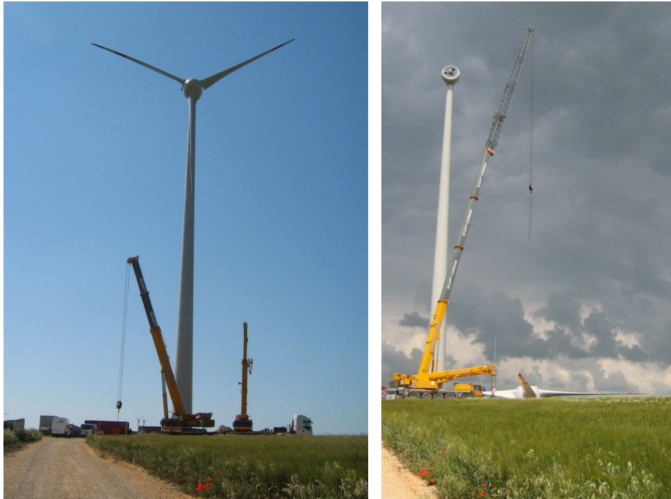
Figura 2: rimozione eliche e mozzo
