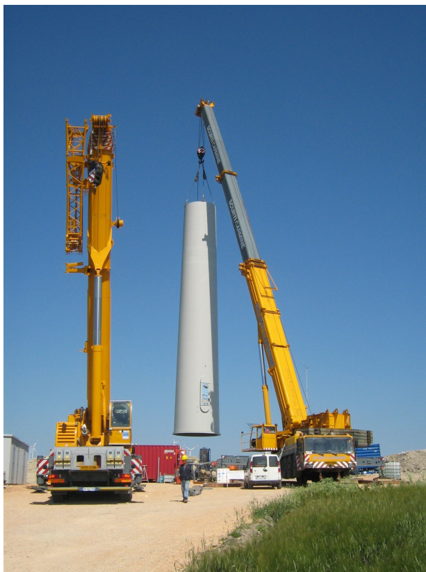
Figura 5: elemento torre smontata da trasportare
