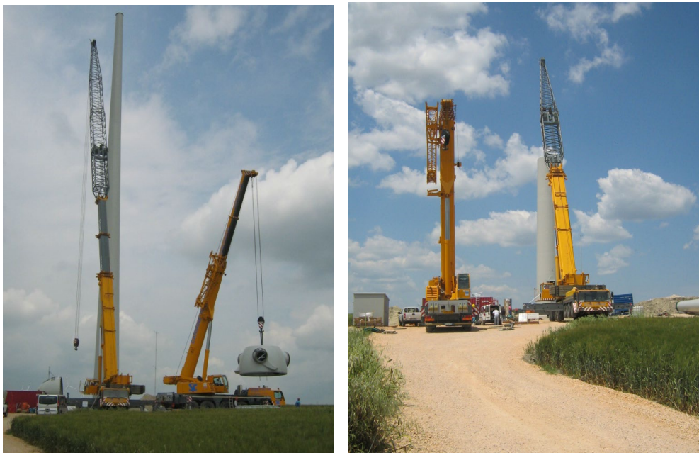
Figura 3: smontaggio navicella
