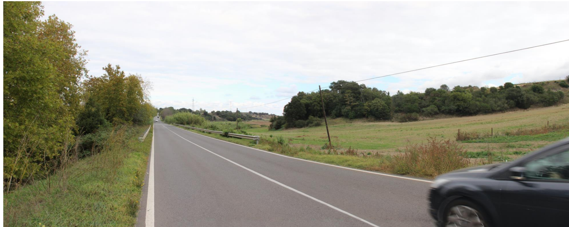
Foto stato di fatto
