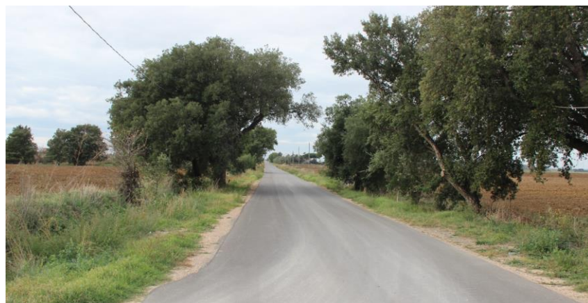
Figura 44 – Strada Provinciale SP4 lungo la quale è prevista la posa del cavo AT in attraversamento della fascia di rispetto di affluenti del “Torrente Arrone”
