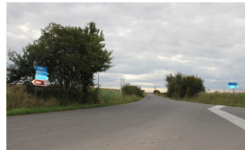
Figura 41 – foto dell'incrocio tra la SP105, lungo la quale è prevista la posa del cavidotto AT in attraversamento dell'area archeologica "Antica Città di Vulci" (codice id m056_006), e la strada provinciale Campigliola lungo la quale il cavidotto At attraversa la fascia di rispetto del Fiume Fiora.
