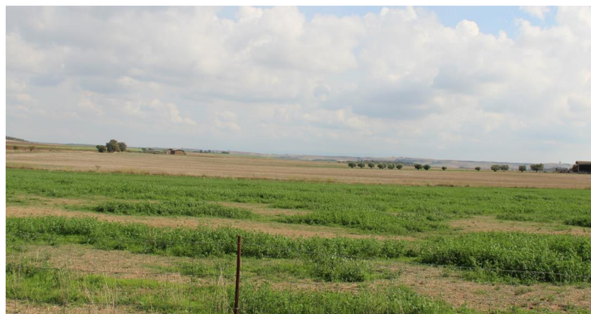
Figura 32 – Area installazione torre T06
