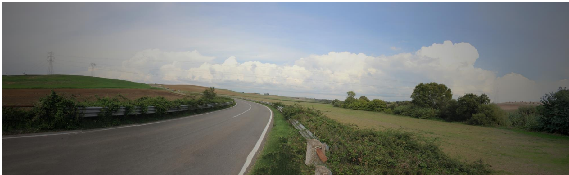
Foto stato di fatto
