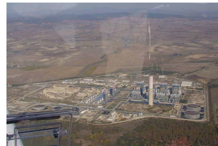
Figura 29: vista area dell'area della centrale: sulla destra la centrale termoelettrica, a sinistra la Centrale elettronucleare Alto Lazio.
