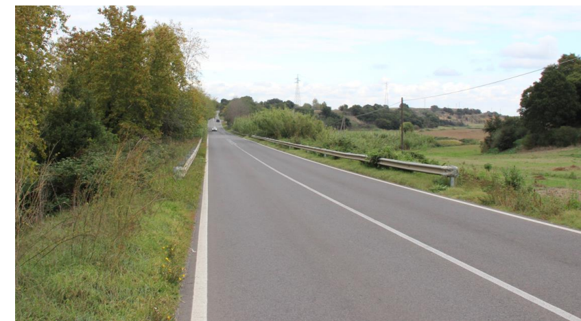
Figura 48 – foto dell'area in cui è previsto l'attraversamento del cavidotto AT sul Fosso Campomorto e nell'area archeologica "Archi di Pontecchio" (codice id m056_0250)
