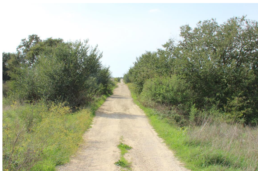
Figura 51 – Attraversamento della strada esistente sull’affluente del “Torrente Arrone” lungo la quale è previsto la posa del cavidotto MT nel tratto di collegamento tra le torri T02 e T05
