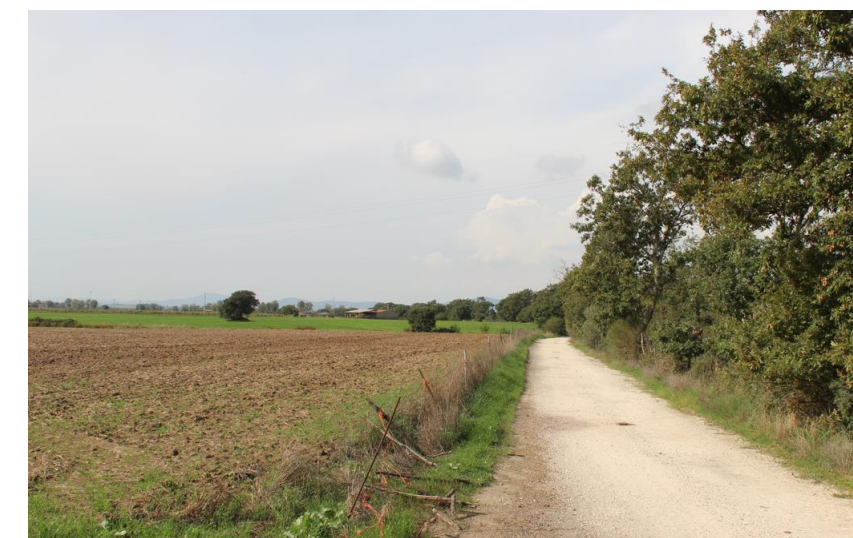
Figura 56 strada esistente che si sviluppa a partire dalla SR312 e conduce alle torri T01 e T03 in attraversamento sul Fosso Timone.
