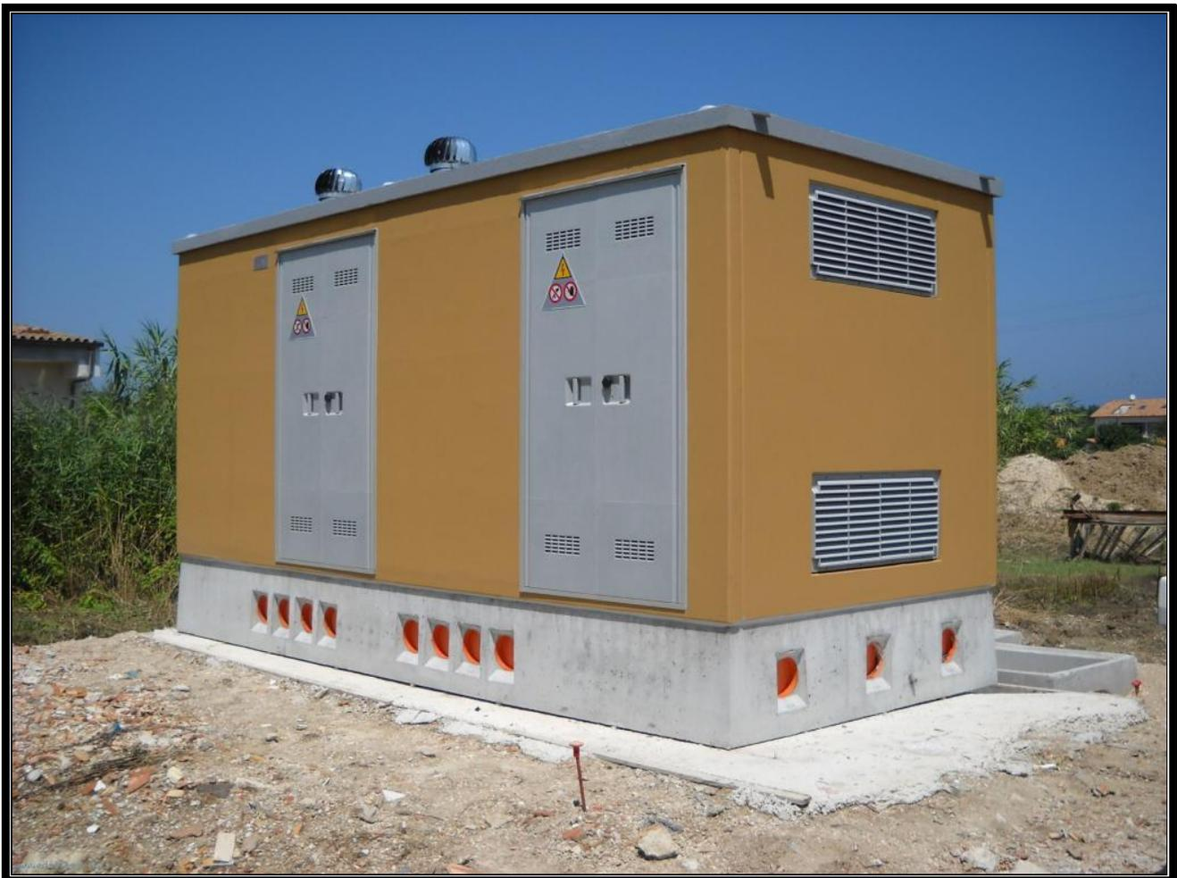
**Figura 8 - ESEMPIO DI CABINA DI PARALLELO MT**
