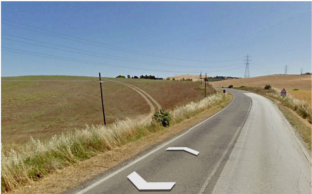
FIGURA 9 – SP 4 in prossimità del lotto
