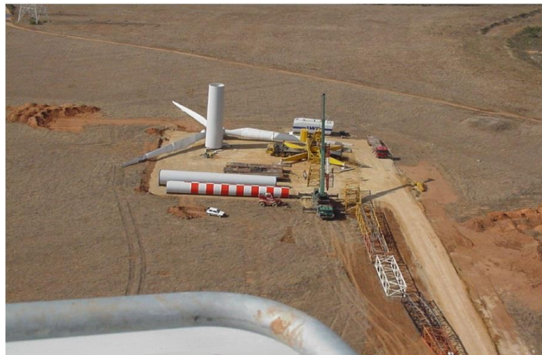
Figura 2 – Piazzola per il montaggio dell'aerogeneratore
