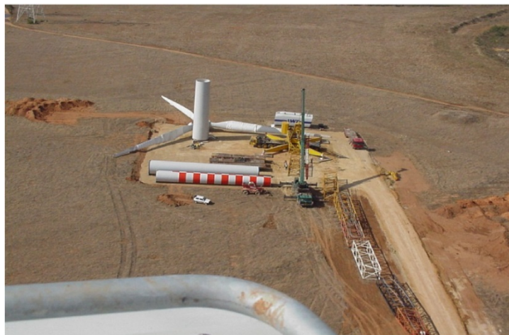
Figura 3 – Piazzola per il montaggio dell'aerogeneratore
