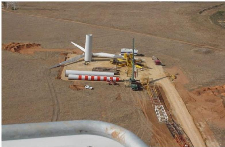
Figura 31 – Piazzola per il montaggio dell'aerogeneratore
