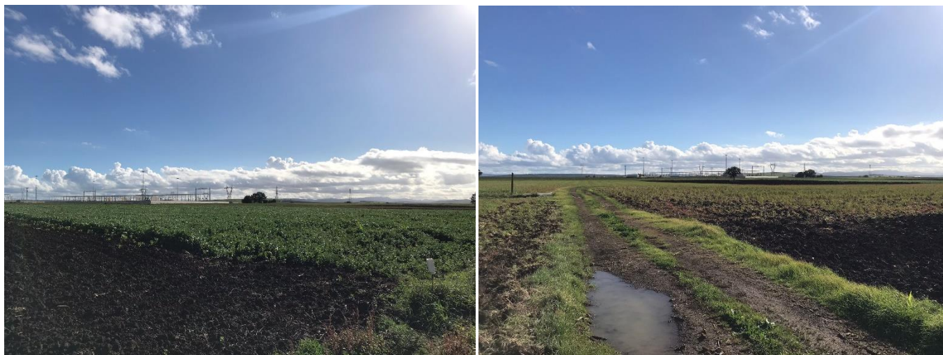
Figura 14: Area sottostazione elettrica
