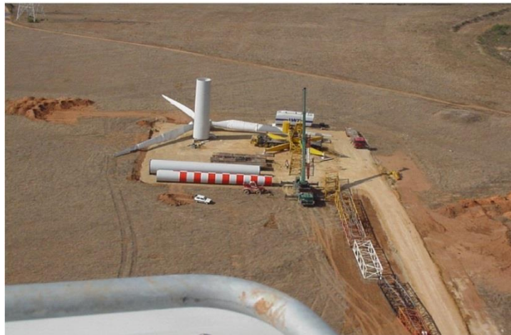
Figura 9 – Piazzola per il montaggio dell'aerogeneratore
