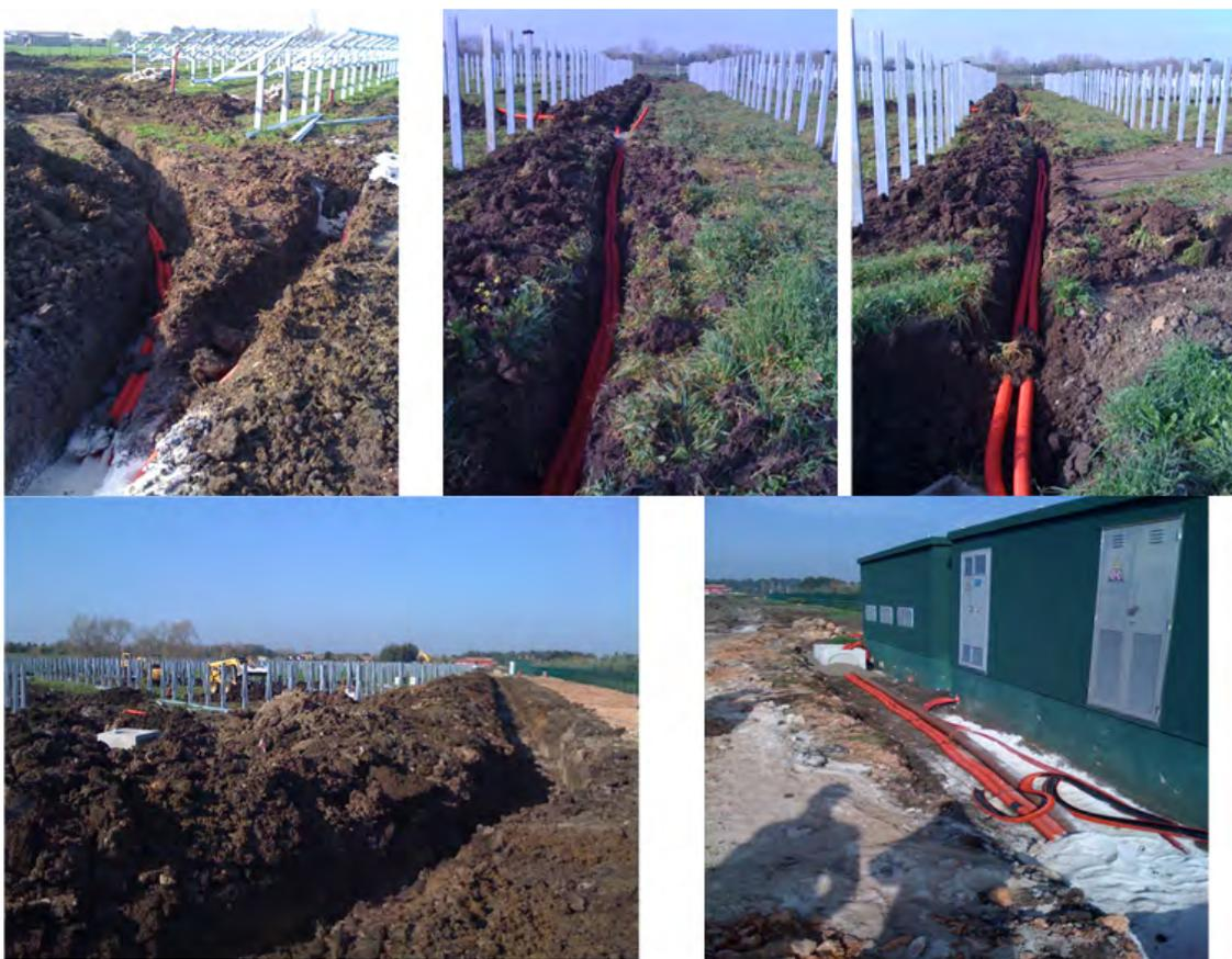
*Fig.20 – Scavi-tipo per collegamenti dei componenti costituenti la centrale fotovoltaica*
