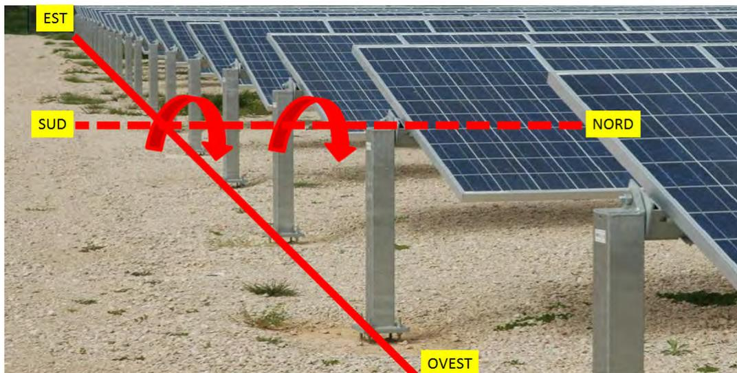
Inoltre, facendo ricorso alla modalità di inseguimento "backtracking", che in alcune fasce orarie prevede una contro rotazione del modulo rispetto a quanto suggerirebbe il naturale tracciamento della posizione del sole, sarà possibile ridurre le perdite per mutuo ombreggiamento nelle prime ore del mattino ed in quelle del tardo pomeriggio.
