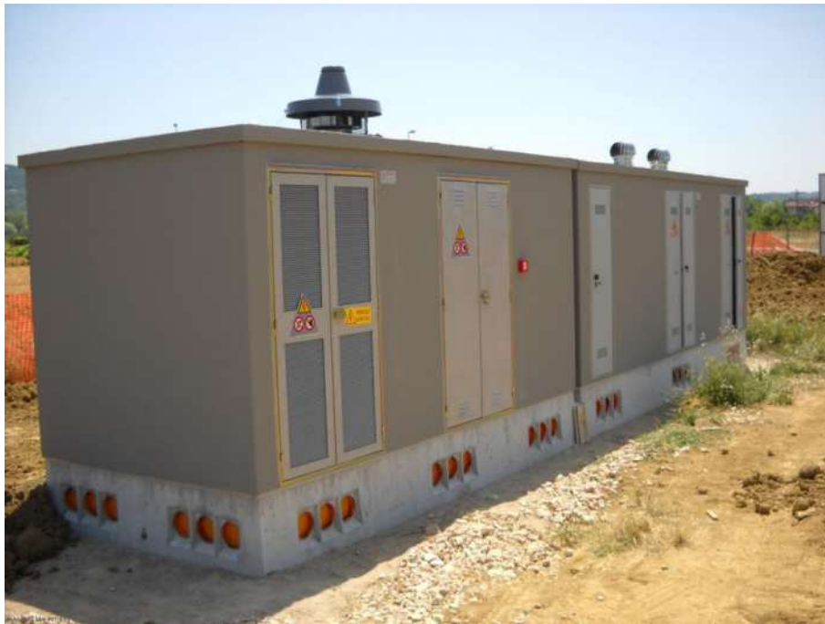
Figura 13. Tipologico delle cabine di conversione e trasformazione.
