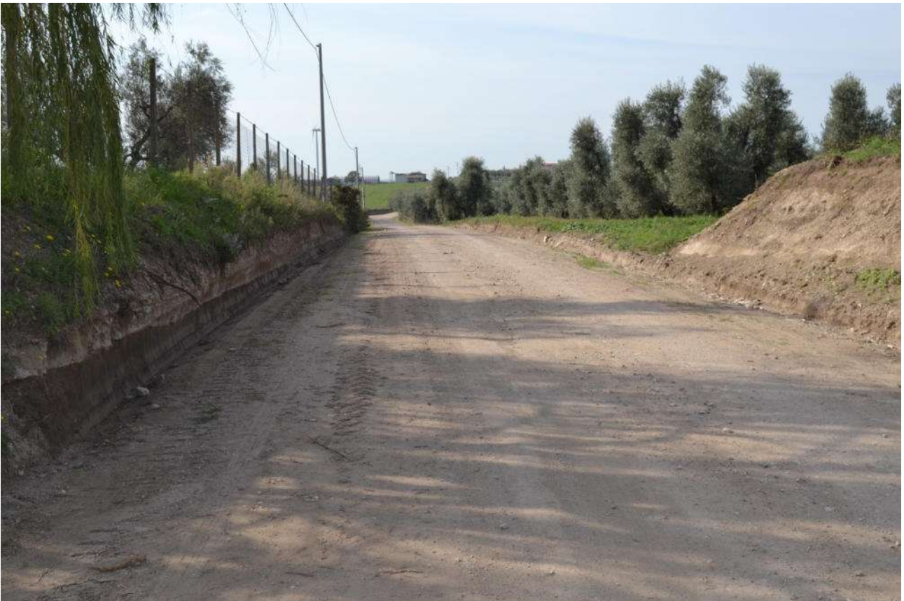
Fig. 38: sopralluogo: tracciato del cavidotto in località Riserva
