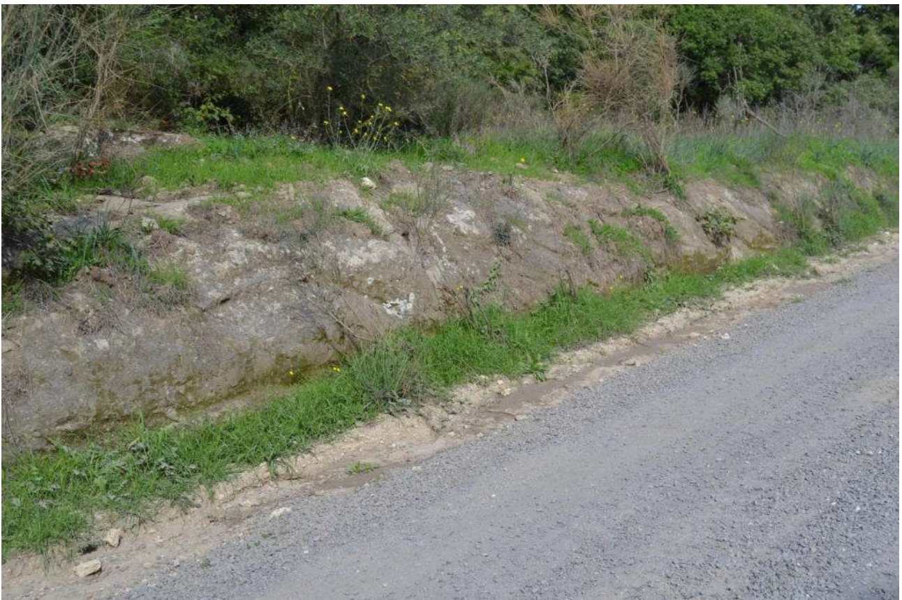
Fig. 34: sopralluogo: tracciato del cavidotto: banco di tufo affiorante lungo la strada
