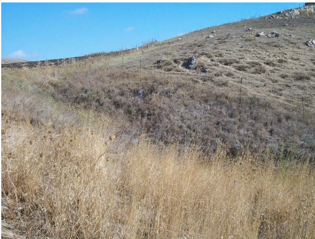
Figura 44: Deposito coesivo superficiale in corrispondenza del sostegno 364
