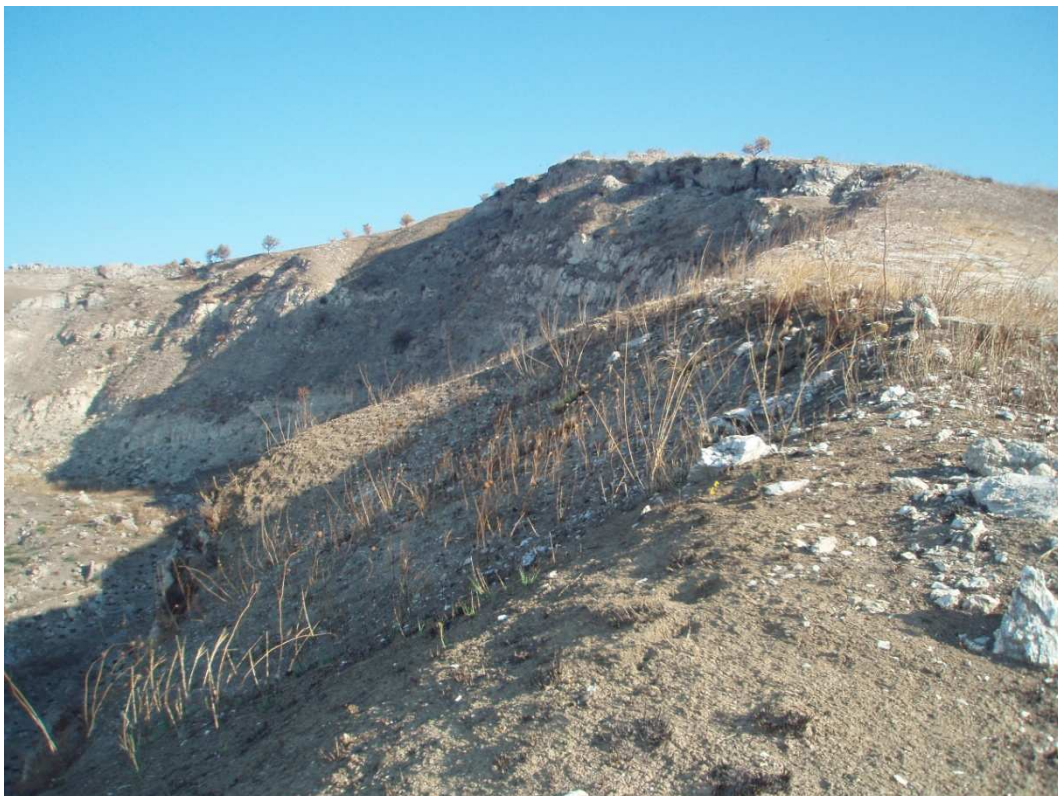
Figura 47: Roccia sub affiorante in corrispondenza del sostegno 245.
