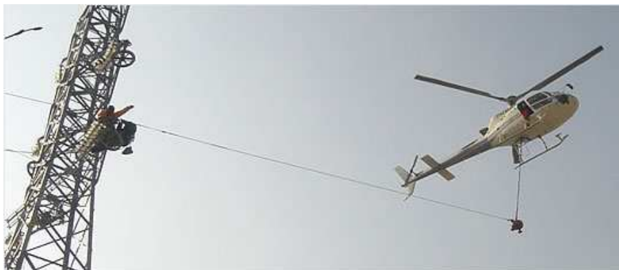
Figura 8: Esempio di tesatura con elicottero
