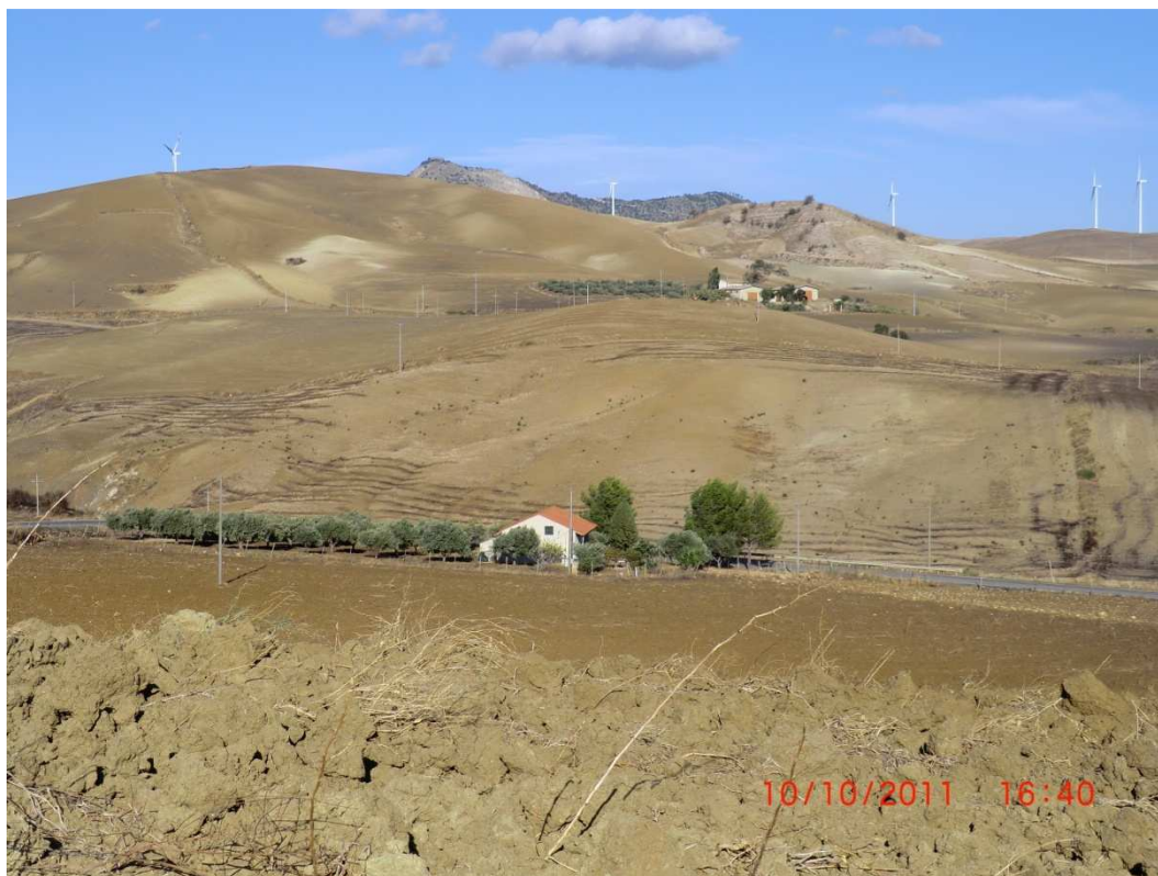
Figura 35: Scivolamenti superficiali in corrispondenza del sostegno 120.
