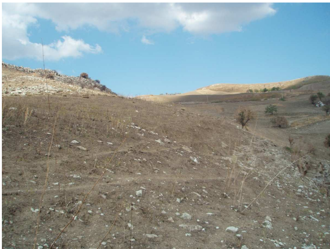
Figura 45: Deposito granulare superficiale in corrispondenza del sostegno 38.
