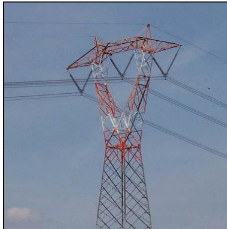
Figura 6-1 Sostegno 380 kV in singola terna.
