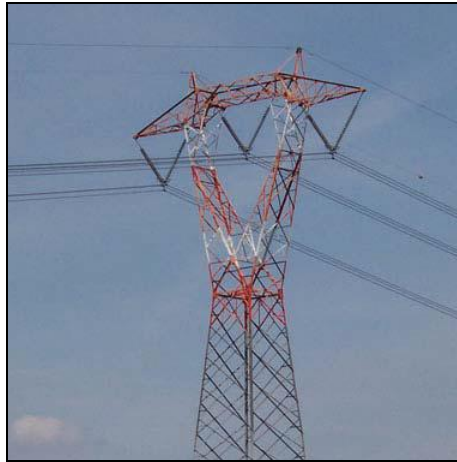
Figura 11-1 Sostegno 380 kV in singola terna.
