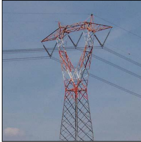
Figura 9-1 Sostegno 380 kV in singola terna.
