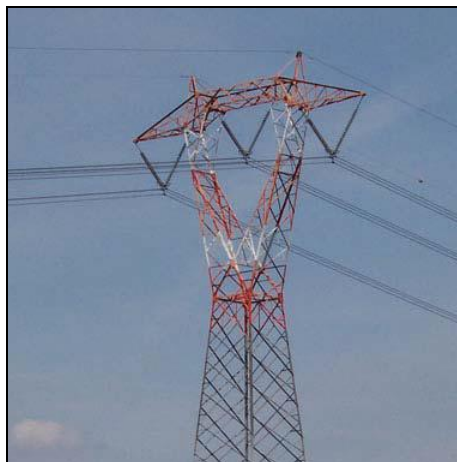
Figura 8-1 Sostegno 380 kV in singola terna.
