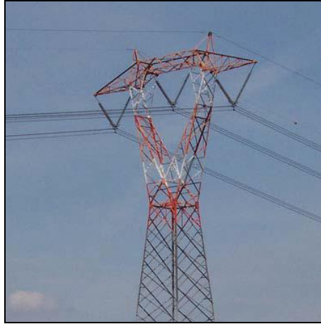
Figura 7-1 Sostegno 380 kV in singola terna.
