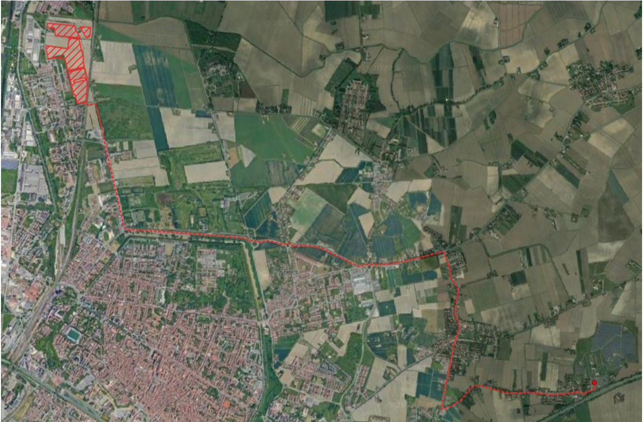
Figura 4 - Inquadramento ortofoto impianto
