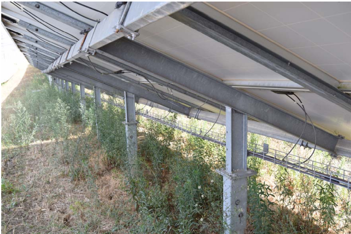
Figura 24 - Vegetazione al di sotto delle file di pannelli – Fonte HE
