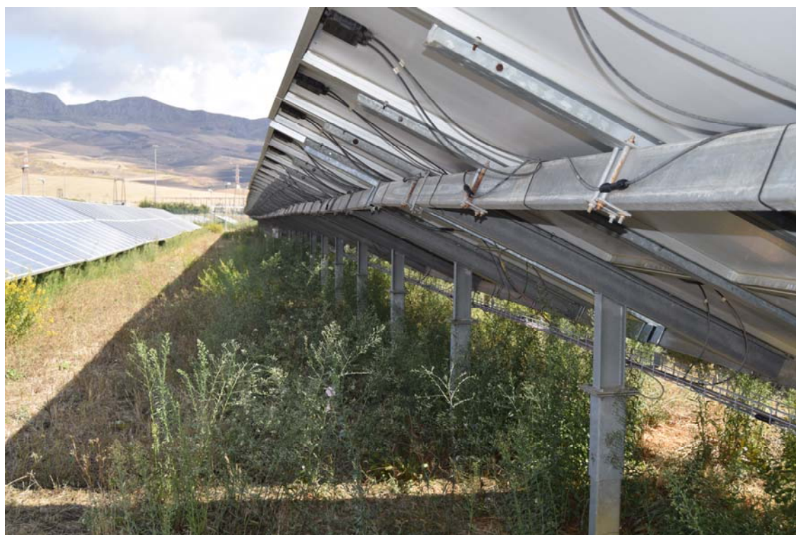
Figura 22 - Vegetazione al di sotto delle file di pannelli – Fonte HE
