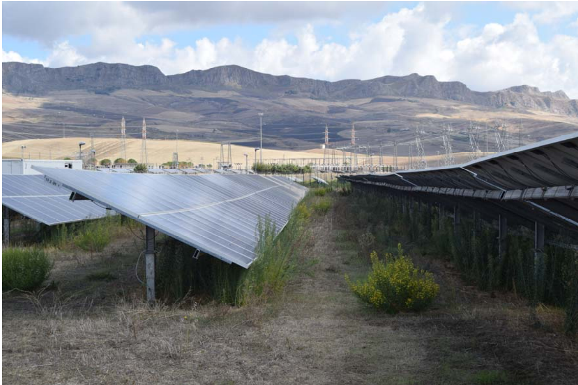
Figura 23 - Vegetazione al di sotto delle file di pannelli – Fonte HE
