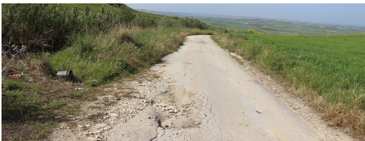
Figura 6 – viabilità locale che verrà utilizzata per raggiungere la posizione della A02 e, proseguendo, le torri A01, A03, A04 – tratto interessato da interventi di sistemazione del manto stradale e dalla posa del cavidotto interno
