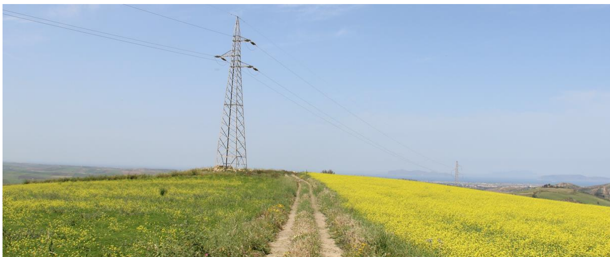
Figura 8 – pista esistente che si snoda dalla strada vicinale “Calvano Recalbesi Torretta Ballata” e che verrà adeguata per raggiungere la torre A03 – lungo tale pista è prevista la posa del cavidotto interno a servizio della torre A03
