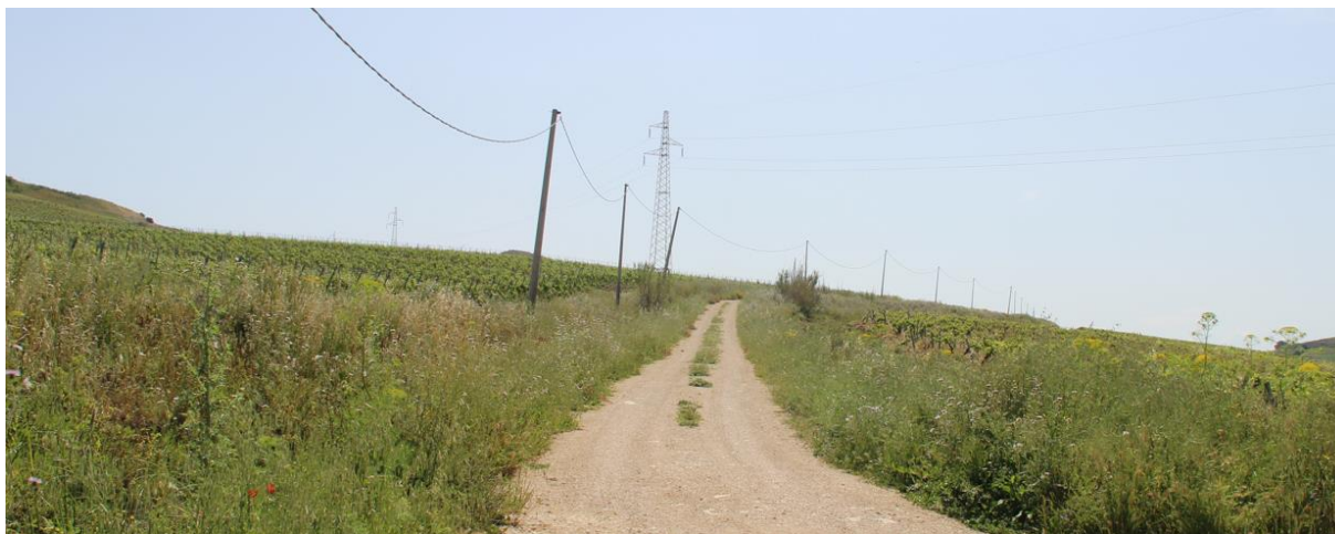
Figura 10 – strada vicinale “Calvano Recalbesi Torretta Ballata” nel tratto in avvicinamento alla torre A04 – la strada sarà adeguata localmente e interessata dalla posa del cavidotto interno
