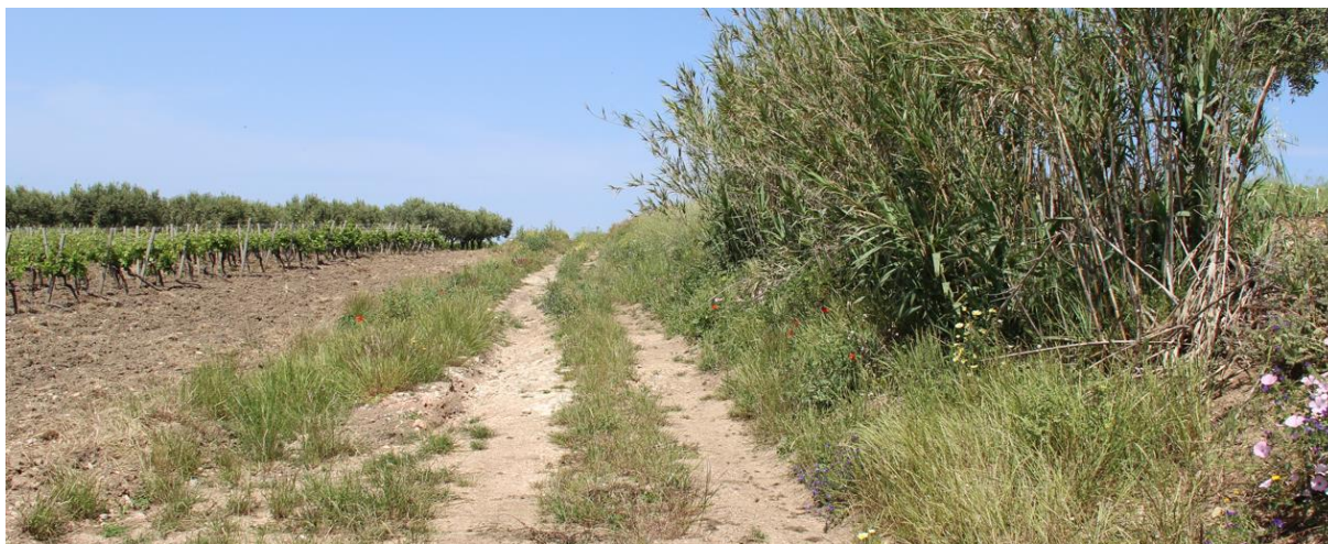
Figura 4 – strada vicinale “Calvano Recalbesi Torretta Ballata” nel tratto in avvicinamento alla torre A01 – tratto che sarà adeguato e interessato dalla posa del cavidotto interno
