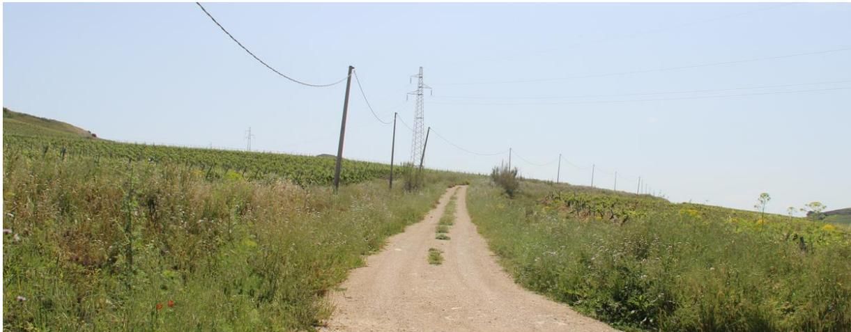
**Figura 18 – strada vicinale “Calvano Recalbesi Torretta Ballata” nel tratto in avvicinamento alla torre A04 – la strada sarà adeguata localmente e interessata dalla posa del cavidotto interno**
