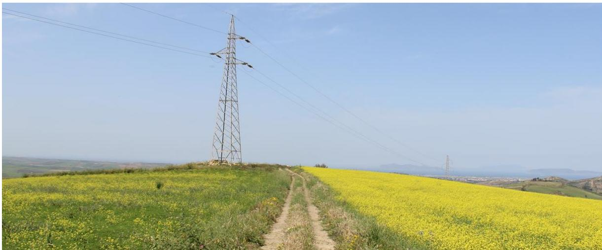
**Figura 16 – pista esistente che si snoda dalla strada vicinale “Calvano Recalbesi Torretta Ballata” e che verrà adeguata per raggiungere la torre A03 – lungo tale pista è prevista la posa del cavidotto interno a servizio della torre A03**
