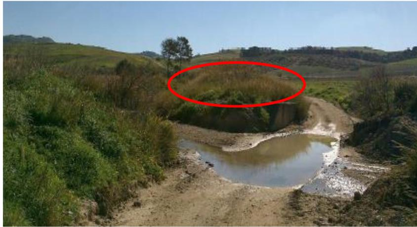
**Figura 3: Foto dell'attraversamento a raso di Contrada Carrubazza su torrente Menta, in corrispondenza del quale è previsto un allargamento temporaneo (indicato in rosso). Come vi rileva dalla foto, non è previsto il taglio di alberi ma di formazioni prative e arbusti bassi.**
