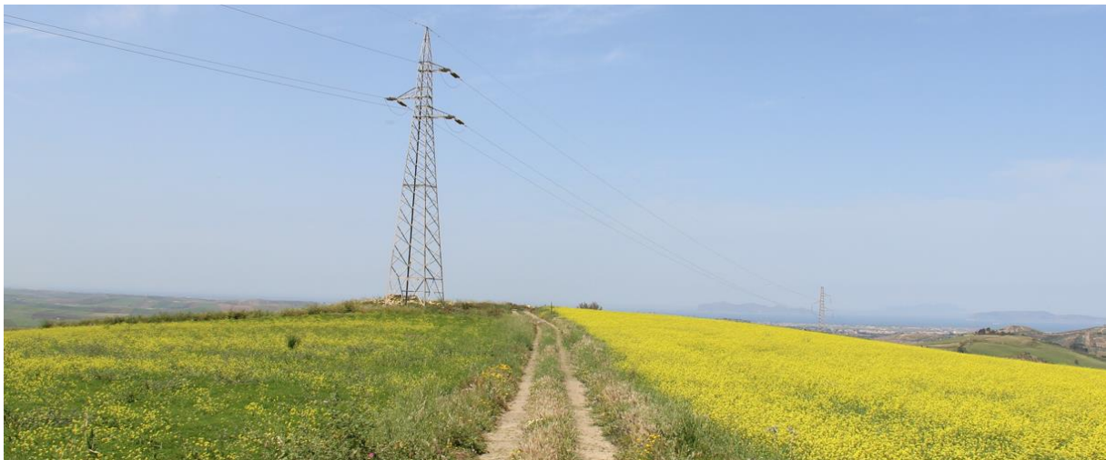
Figura 8 – pista esistente che si snoda dalla strada vicinale “Calvano Recalbesi Torretta Ballata” e che verrà adeguata per raggiungere la torre A03 – lungo tale pista è prevista la posa del cavidotto interno a servizio della torre A03
