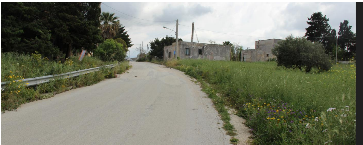
Figura 22 – Tratto della SP36 in corrispondenza dell'incrocio con Contrada Carrubazza interessato dalla posa del cavidotto interno
