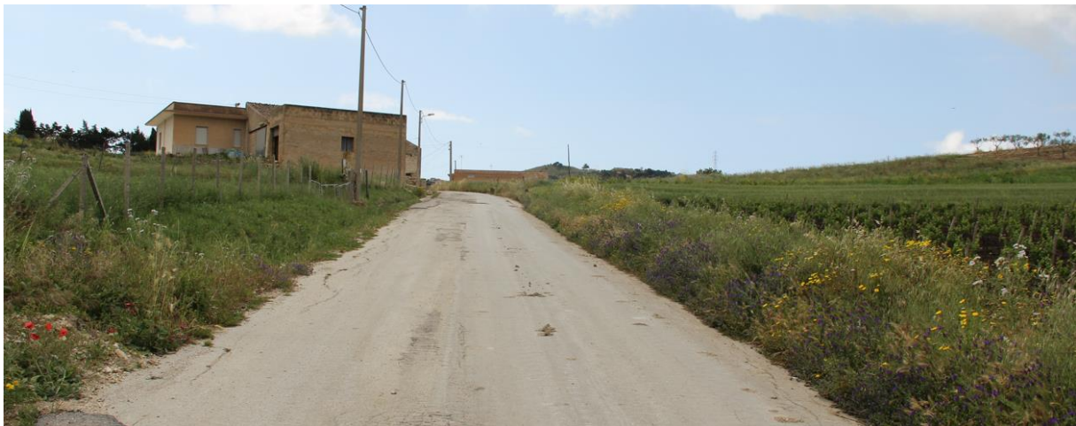
Figura 25 – via Vincenzo Fazio interessata dalla posa del cavidotto esterno in avvicinamento dalla futura stazione di rete
