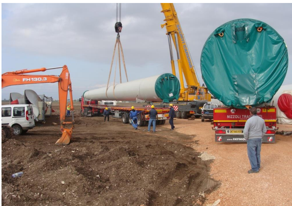
Figura 6: elementi torre smontata da trasportare
