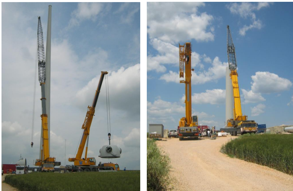
Figura 3: smontaggio navicella
