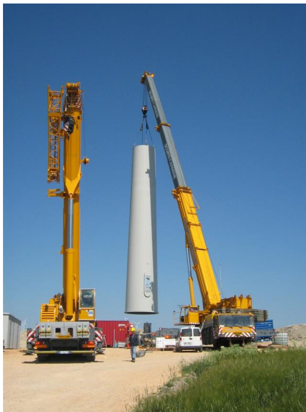
Figura 5: elemento torre smontata da trasportare
