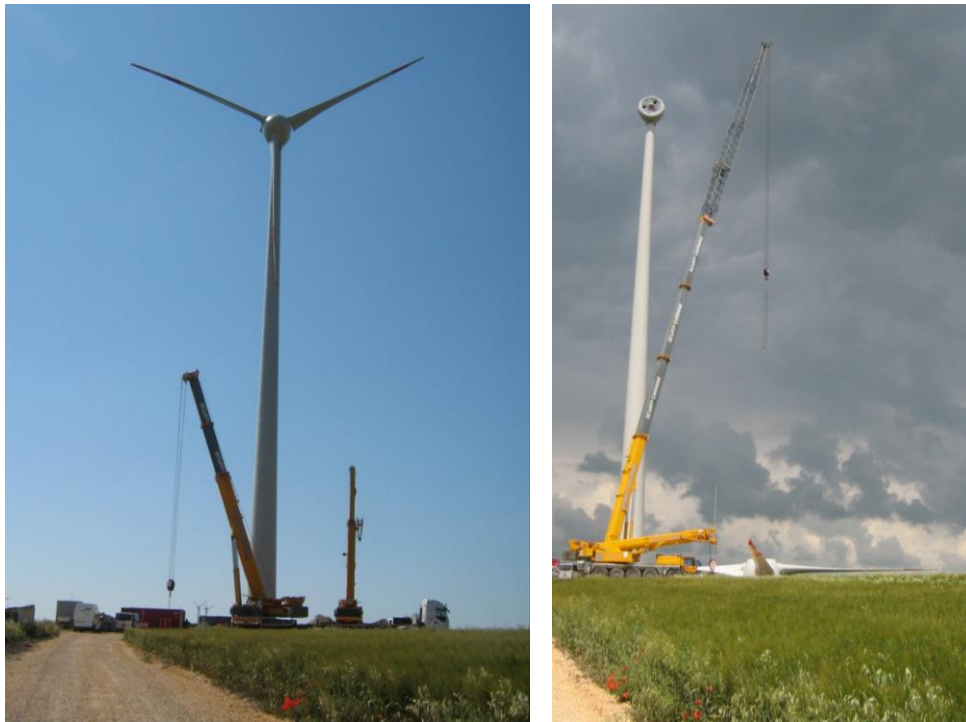
Figura 2: rimozione eliche e mozzo
