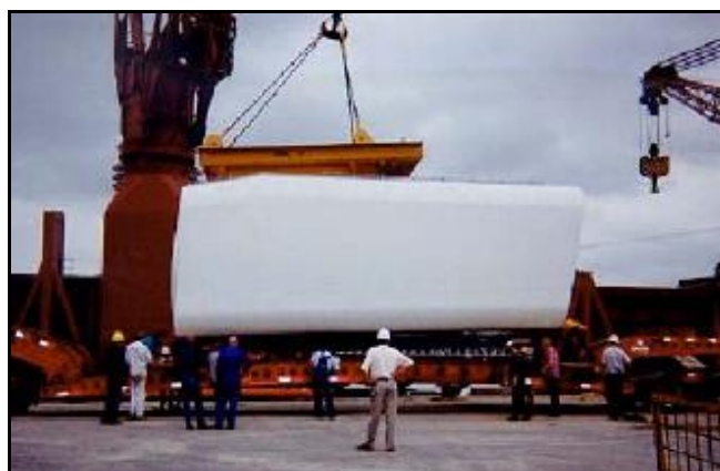
Figura 10: trasporto della navicella
