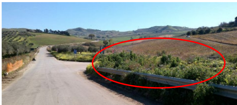
Figura 5: Foto dell'incrocio tra la SP52 e la SP36 in corrispondenza del quale è previsto un allargamento temporaneo (indicato in rosso) ricadente in aree boscate. Come vi rileva dalla foto, non è previsto il taglio di alberi ma di formazioni prative e arbusti bassi.
