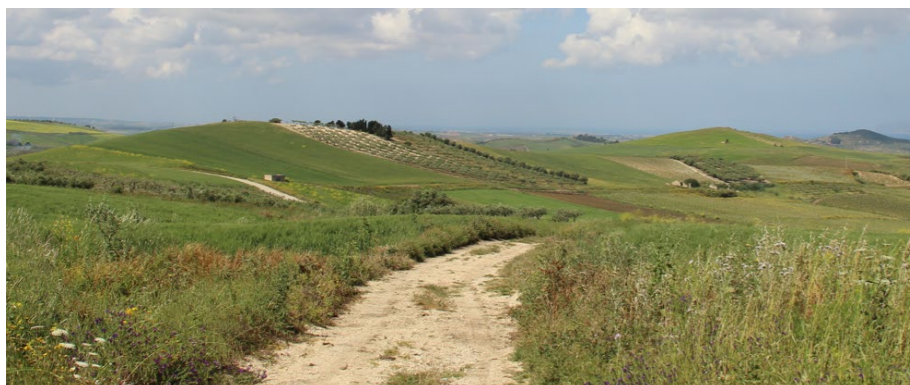
Figura 3: Tratto della strada vicinale Racarrume ricadente nella fascia di tutela dell'affluente del torrente Menta e che verrà adeguata per consentire l'accesso agli aerogeneratori A08 e A09
