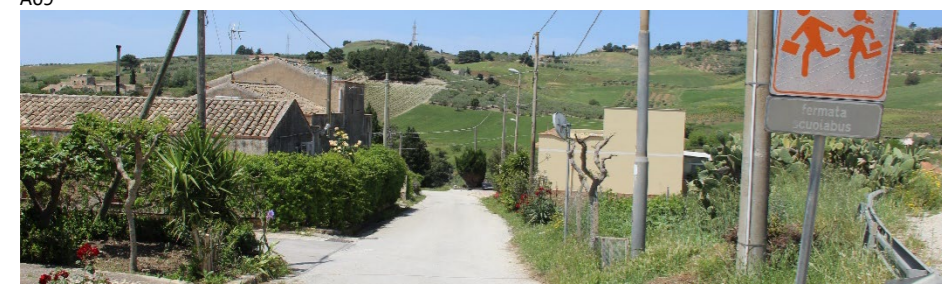
Figura 11 – Strada di passaggio del cavo esterno AT per l'arrivo in SSE
