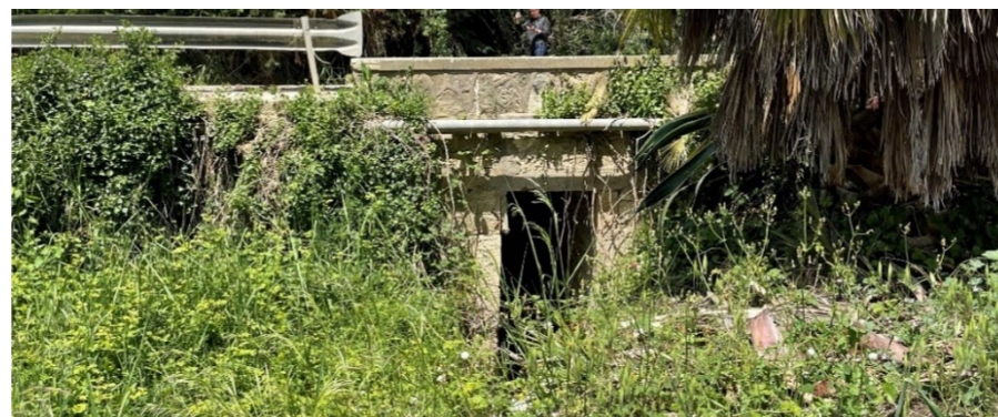
Figura 7 – Attraversamento del Fosso Canalotti
