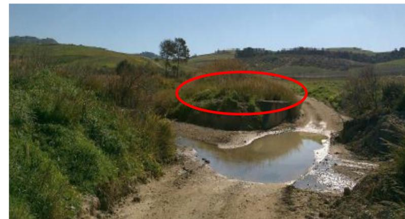
Figura 6: Foto dell'attraversamento a raso di Contrada Carrubazza su torrente Menta, in corrispondenza del quale è previsto un allargamento temporaneo (indicato in rosso). Come vi rileva dalla foto, non è previsto il taglio di alberi ma di formazioni prative e arbusti bassi.
