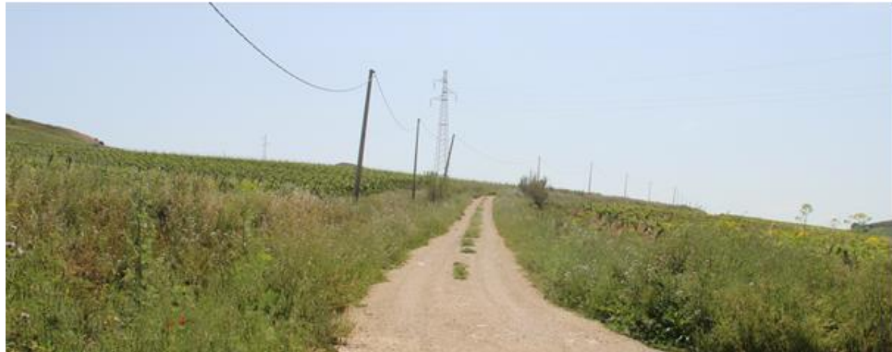
Figura 7: Strada vicinale "Calvano Recalbesi Torretta Ballata" nel tratto in avvicinamento alla torre A04 – la strada sarà adeguata localmente e interessata dalla posa del cavidotto interno
