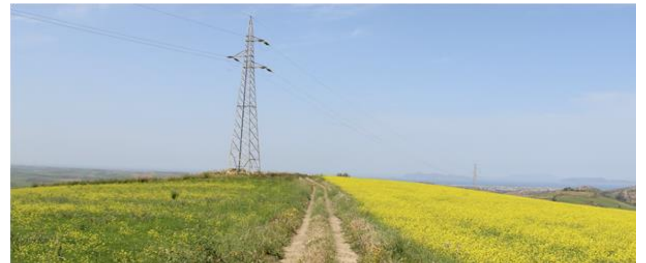
Figura 6: Pista esistente che si snoda dalla strada vicinale "Calvano Recalbesi Torretta Ballata" e che verrà adeguata per raggiungere la torre A03 – lungo tale pista è prevista la posa del cavidotto interno a servizio della torre A03
