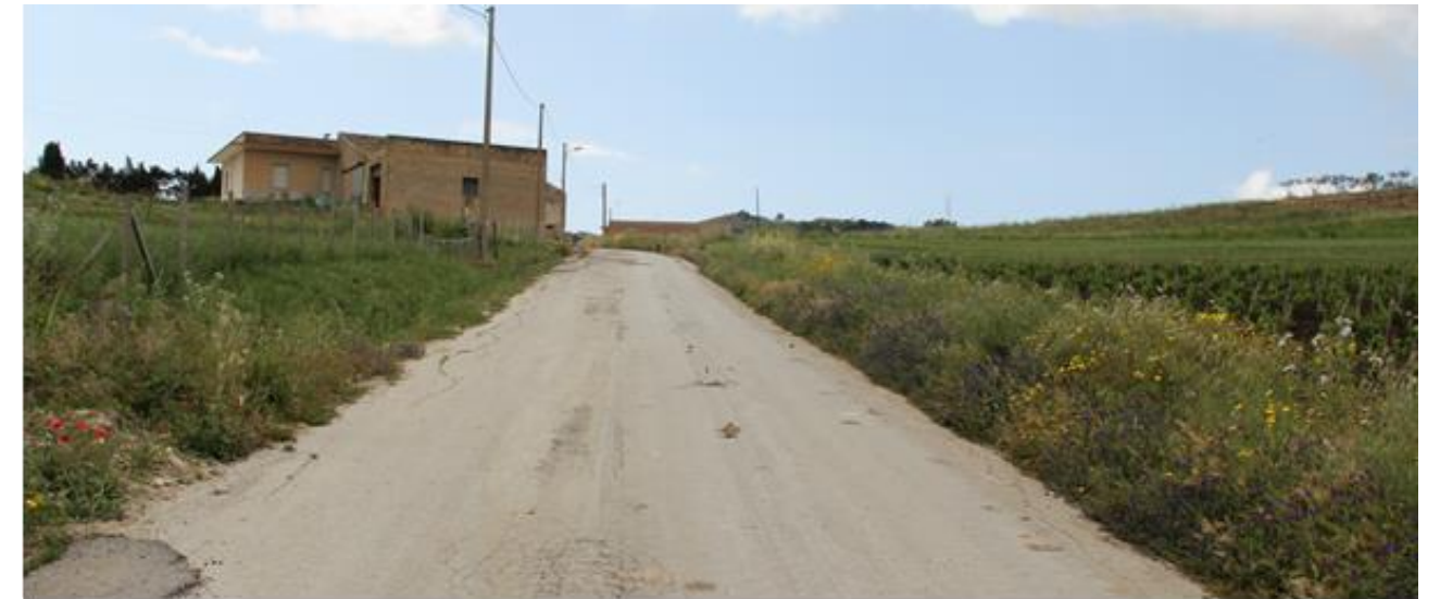
Figura 22: Via Vincenzo Fazio interessata dalla posa del cavidotto esterno in avvicinamento dalla futura stazione di rete
