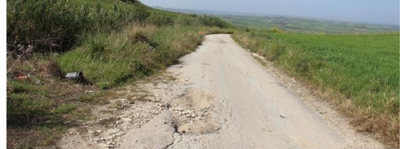
Figura 4: Viabilità locale che verrà utilizzata per raggiungere la posizione della A02 e, proseguendo, le torri A01, A03, A04 – tratto interessato da interventi di sistemazione del manto stradale e dalla posa del cavidotto interno
