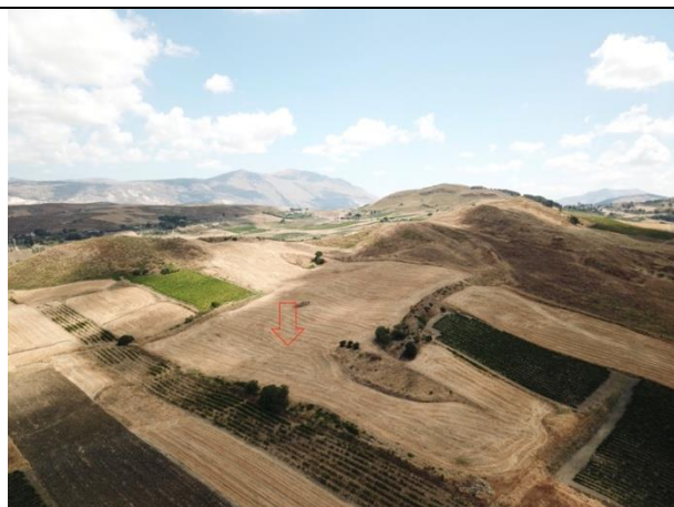
Area installazione aerogeneratore A7
