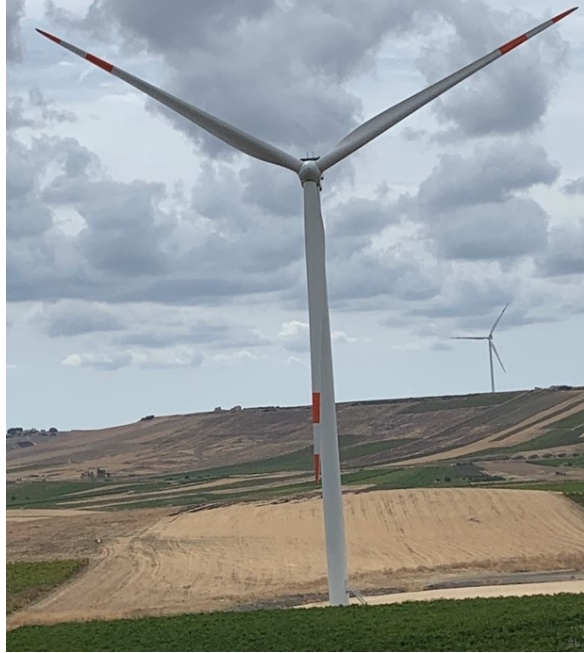
Figura 8 - Aerogeneratore con pale a bande rosse (a destra) presso la centrale eolica "VRG Wind 060" della VGE nel territorio di Marsala (TP).
