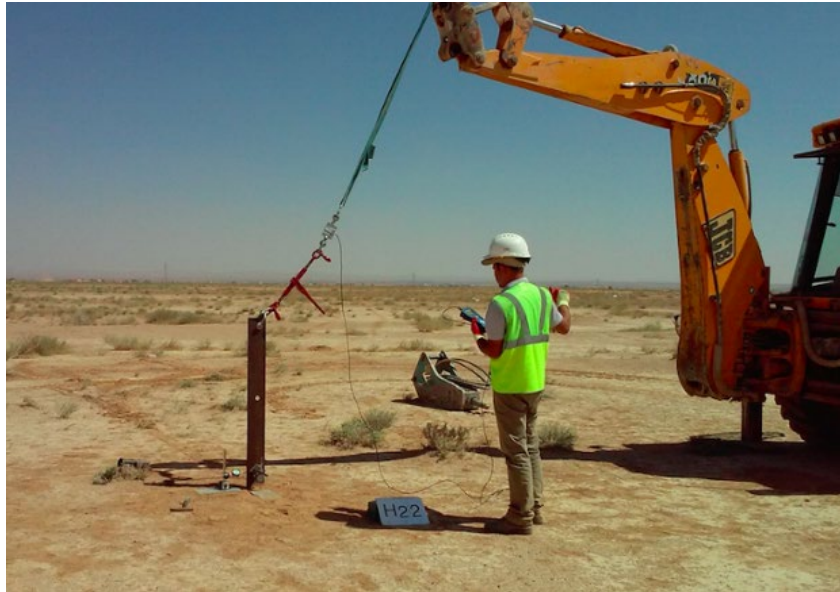
Figura 5-11 – Esecuzione di pull out test
