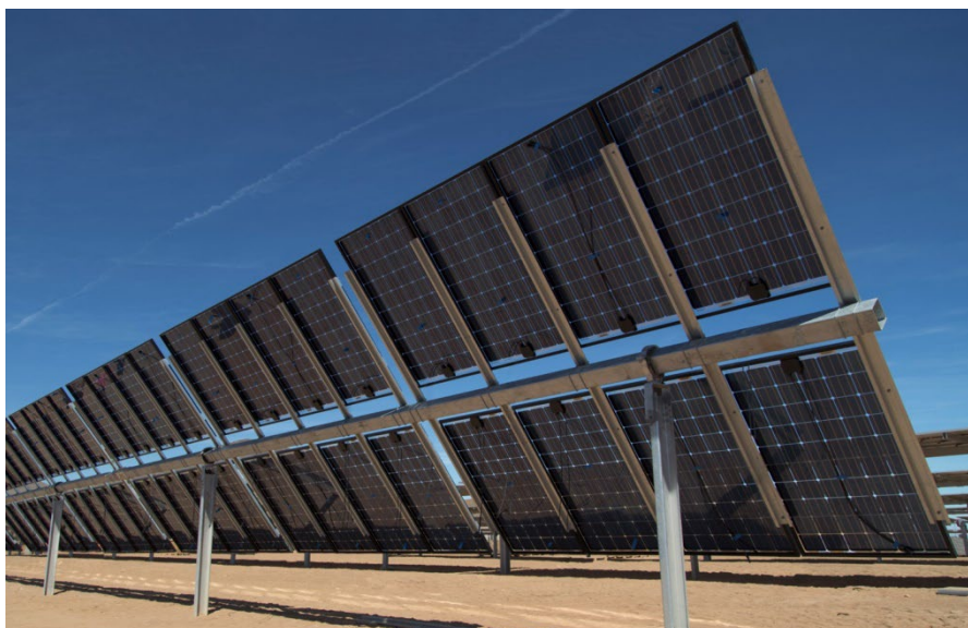
Figura 4-2 – Esempio di struttura + modulo FV bifacciale
