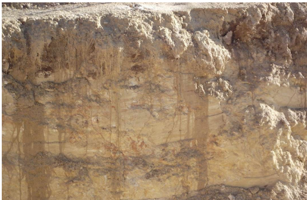
Figura 4-3 – Calcareniti di Gravina: scavo di fondazione localizzato in prossimità dell'area in studio
