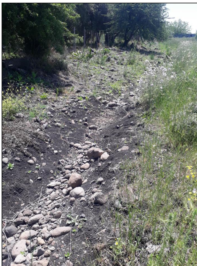
Fig. 11: Via di impluvio presente entro il settore settentrionale del LOTTO-2.
